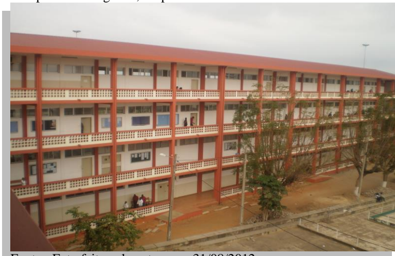
Foto 1 : Edifício onde funciona a Faculdade de Ciências Sociais Campus da Lhanguene, Maputo.
