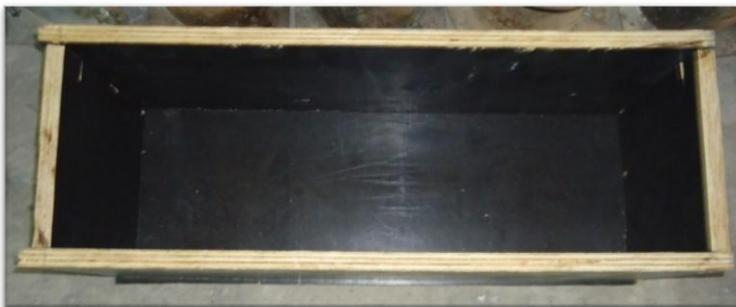
Figura 38 – Forma do pilar liso
