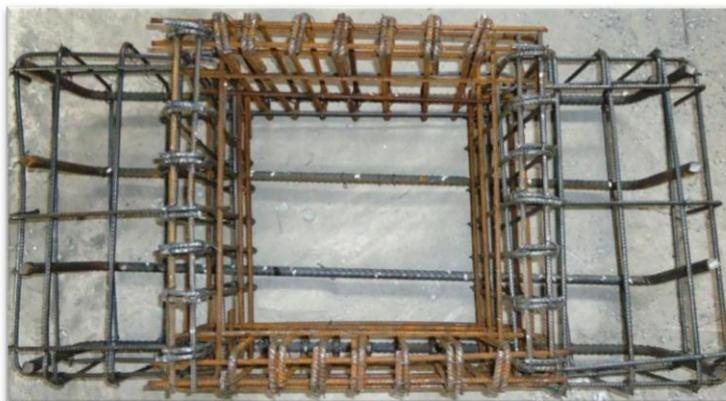
Figura 424 – Armadura do bloco liso/monolítico
