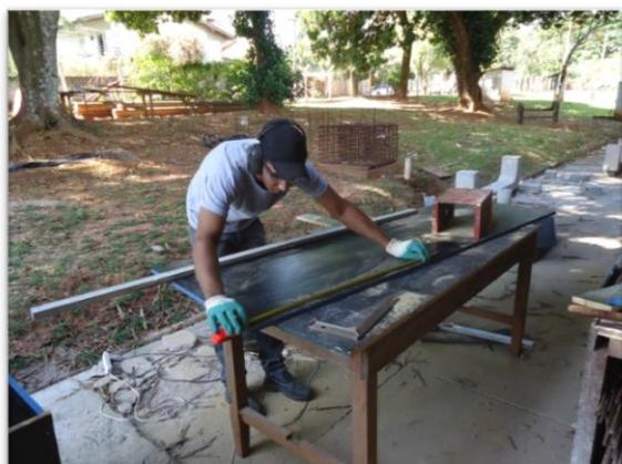
Figura 34 – Marcação das dimensões da forma
