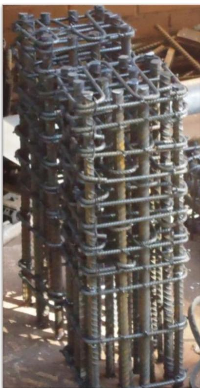
Figura 413 – Armadura do pilar
