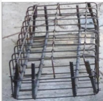
Figura 405 – Armadura do bloco monolítico
