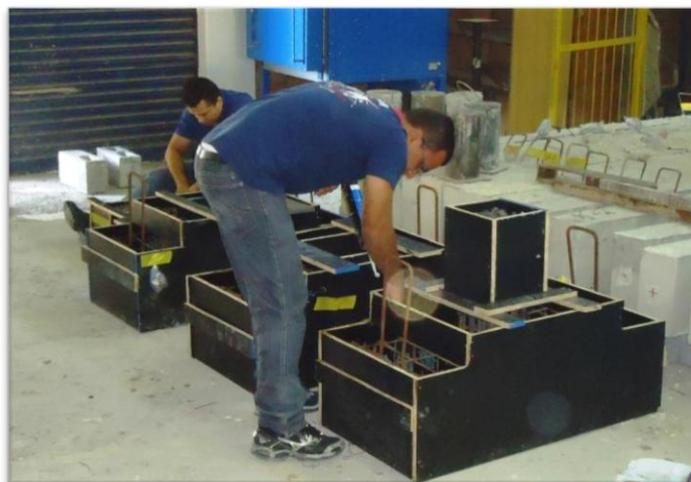
Figura 42 – Passagem de desmoldante/preparo das peças para concretagem
