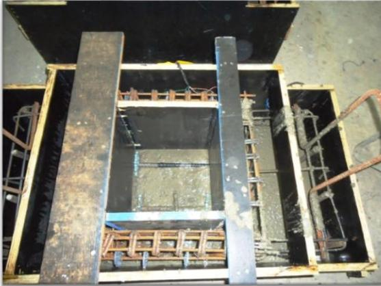
**a) Concretagem do bloco liso**
