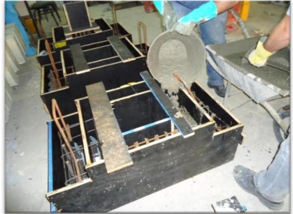
**b) Concretagem do bloco liso**
