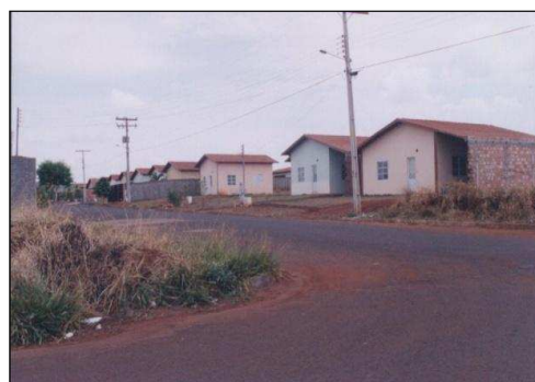
Figura 25 – Rio Verde: conjunto habitacional para funcionários da Perdigão que têm rendimento de no máximo 5 salário mínimos.
