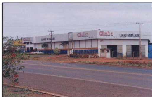
Figura 10 – Rio Verde: vista parcial da fábrica de estruturas metálicas Calles. Fonte: LACERDA JÚNIOR, 2004.
