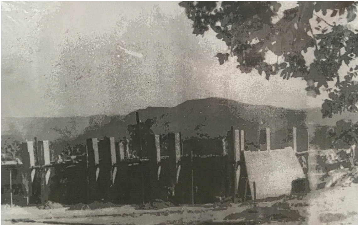
Figura 36- Obras do hospital regional Getúlio Vargas.
