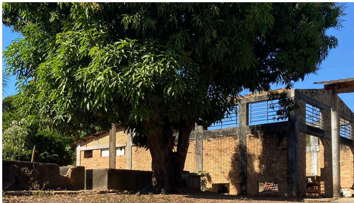
Figura 59- Casa do Motor - FBC.
