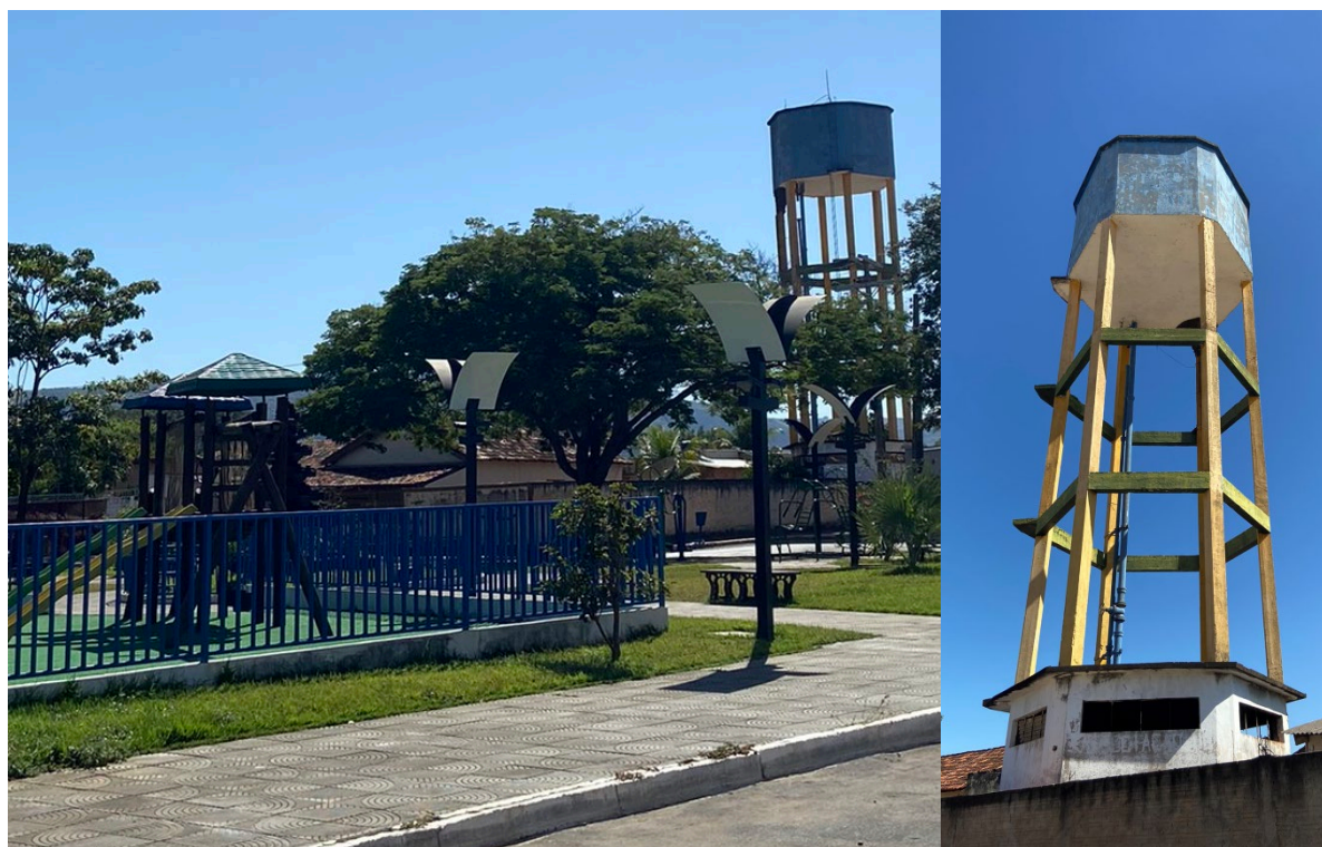
Figura 60- Praça da Vila Ceará e Caixa D'Água - FBC.
