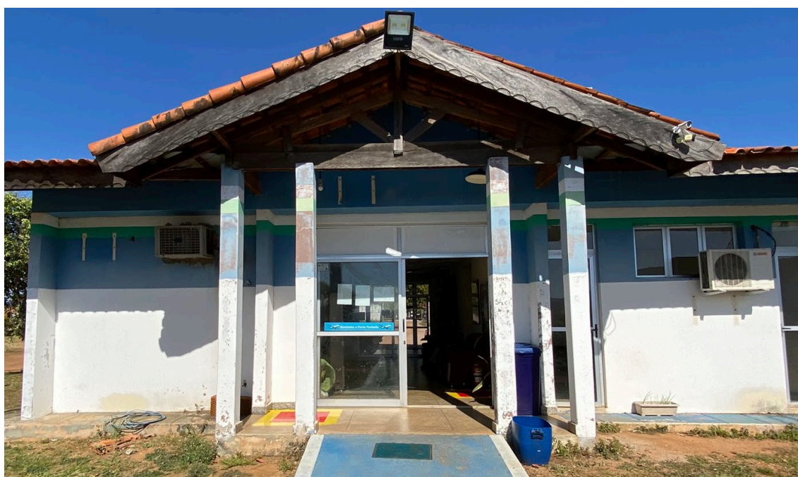
Figura 51- Edificação administrativa do Aeroporto Cid Lana - FBC.
