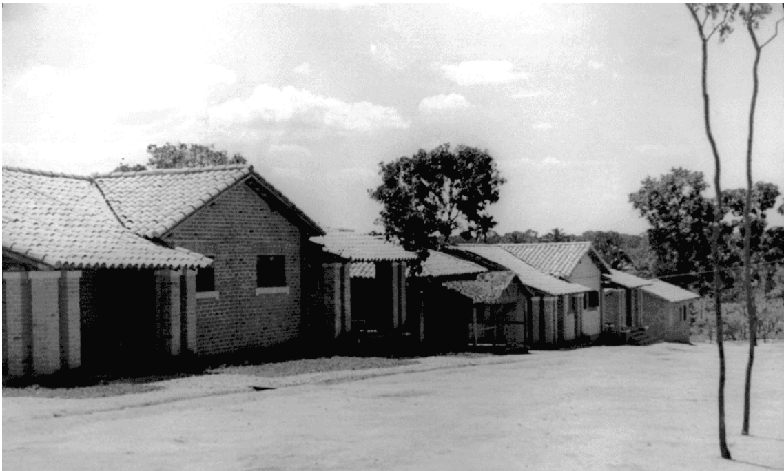
Figura 43- Conjunto de casas residenciais construídas pela FBC em Aragarças-Go.
