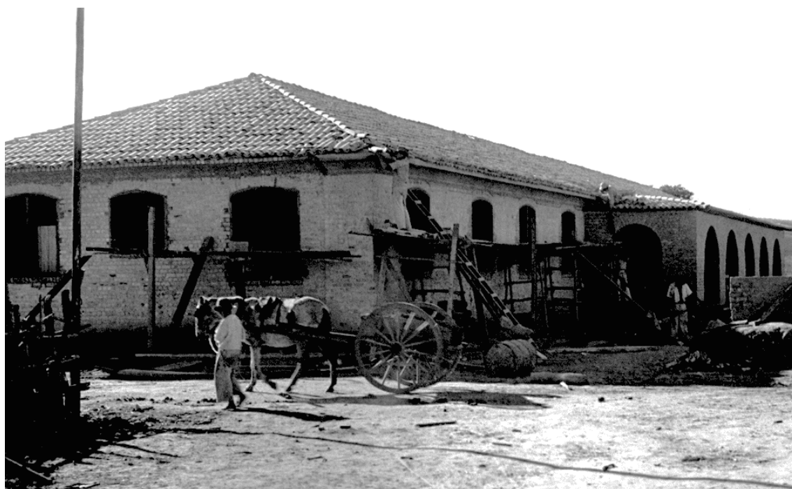
Figura 17- Base da FBC em Barra Goiana.
