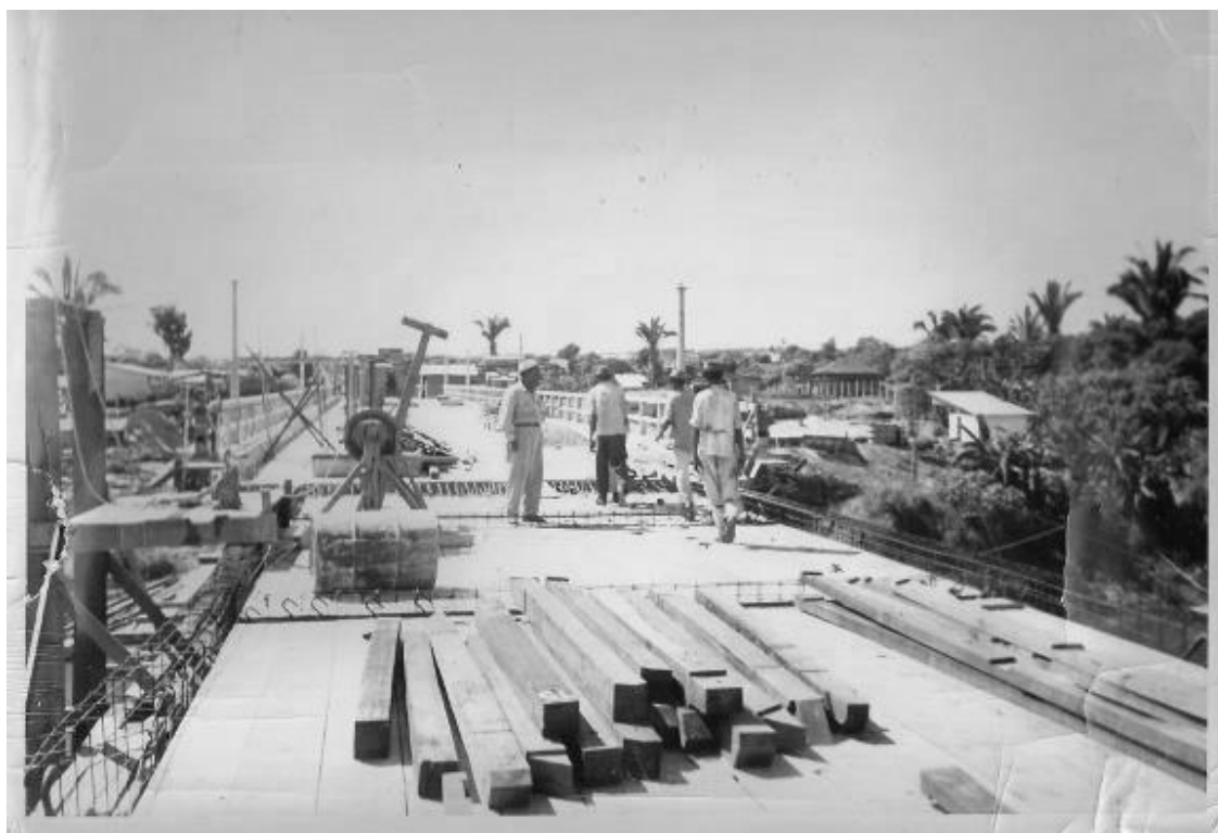
Figura 20- Construção de estradas e ponte sobre o rio Araguaia, em Aragarças.
