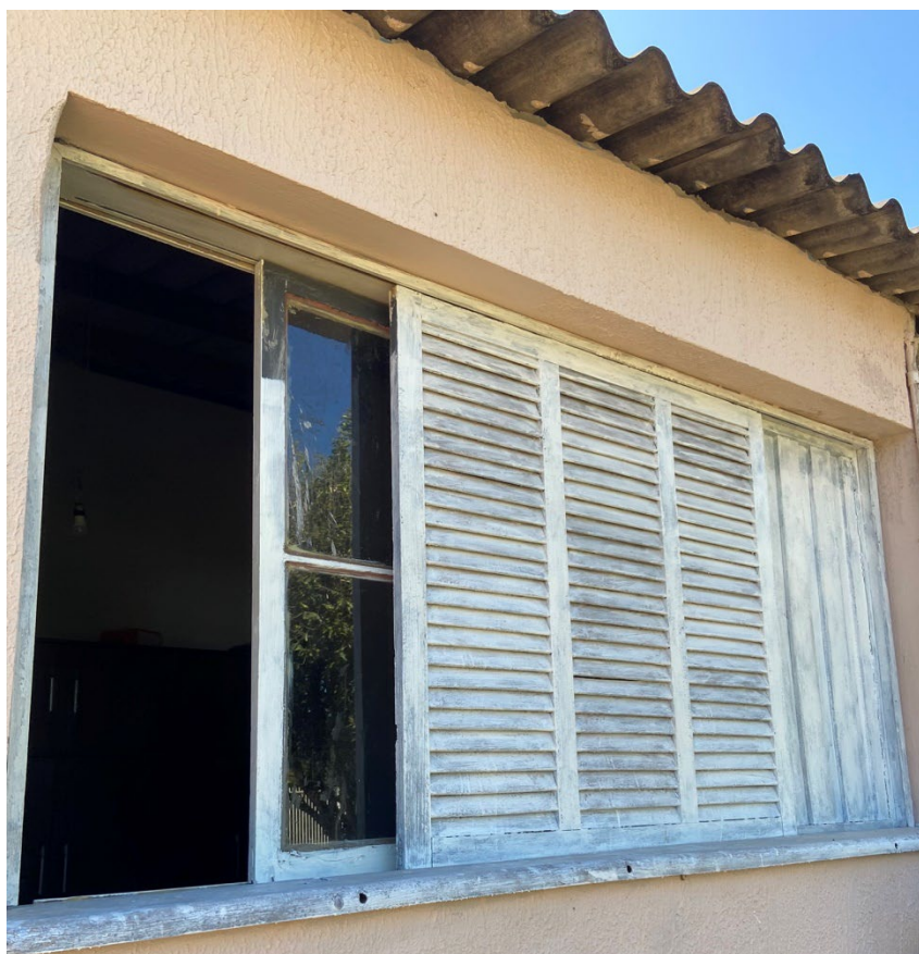
Figura 55- Janelas de correr original em madeira e vidro, Vila Ceará - FBC.
