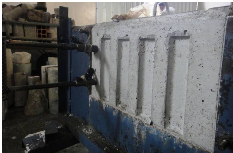
Figura 3.23 - Preparo para moldagem dos consolos do modelo M6, com chave de cisalhamento e epóxi.
