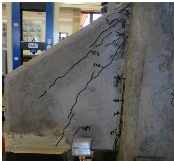
(d) Esmagamento da biela no consolo 2 ao final do ensaio
