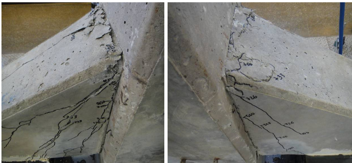
(e) Esmagamento do concreto no canto superior do consolo 1 ao final do ensaio
