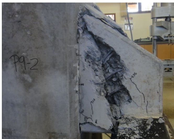
(e) Expulsão do cobrimento da armadura de costura do consolo
