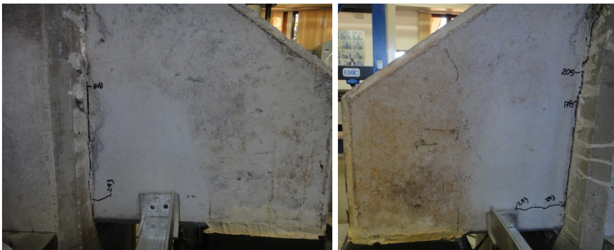
Figura 4.19 - Fissuração na região do tirante próximo ao pilar do modelo em duas etapas M9B.
