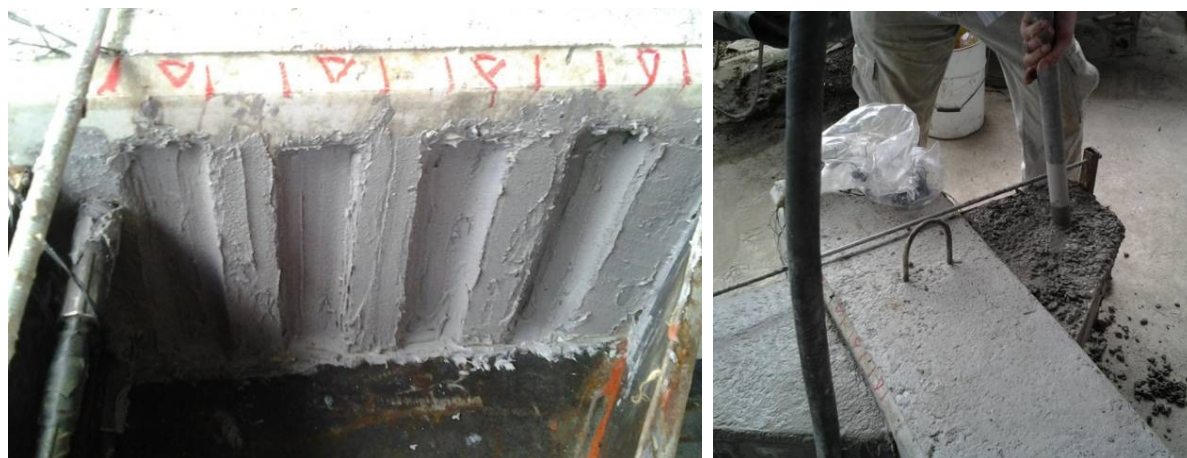
Figura 3.22 - Preparo e moldagem dos consolos do modelo M5, com chave de cisalhamento e epóxi.
