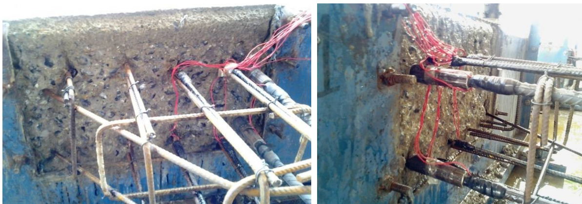
Figura 3.18 - Junta entre o pilar e o consolo do modelo M7, antes da moldagem do consolo.
