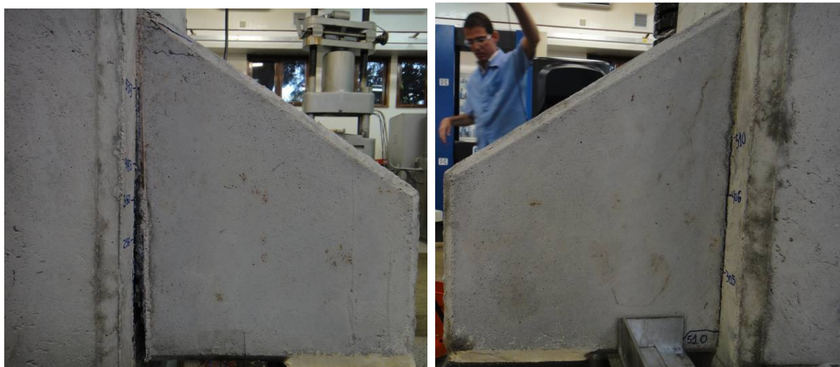
(a) Ruína do consolo 1 com abertura excessiva da junta.
