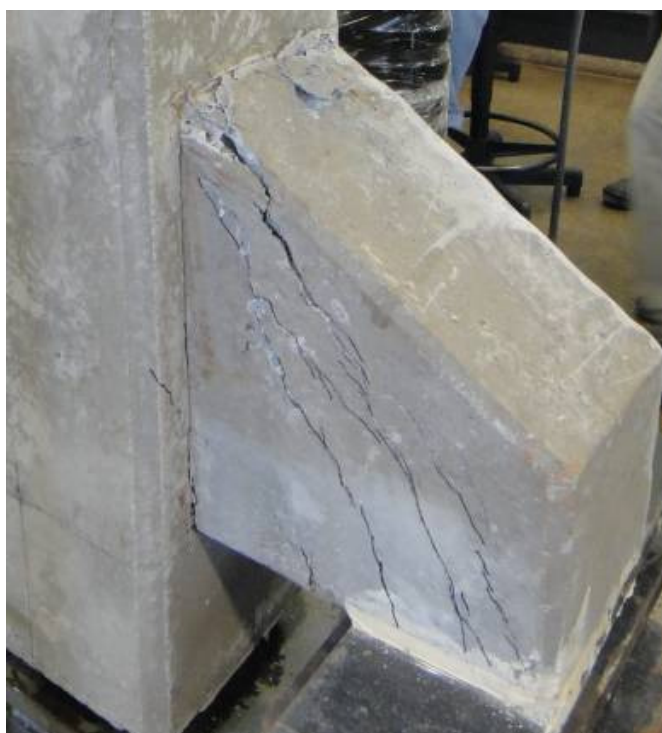
(c) Esmagamento do concreto no canto superior do consolo ao final do ensaio
