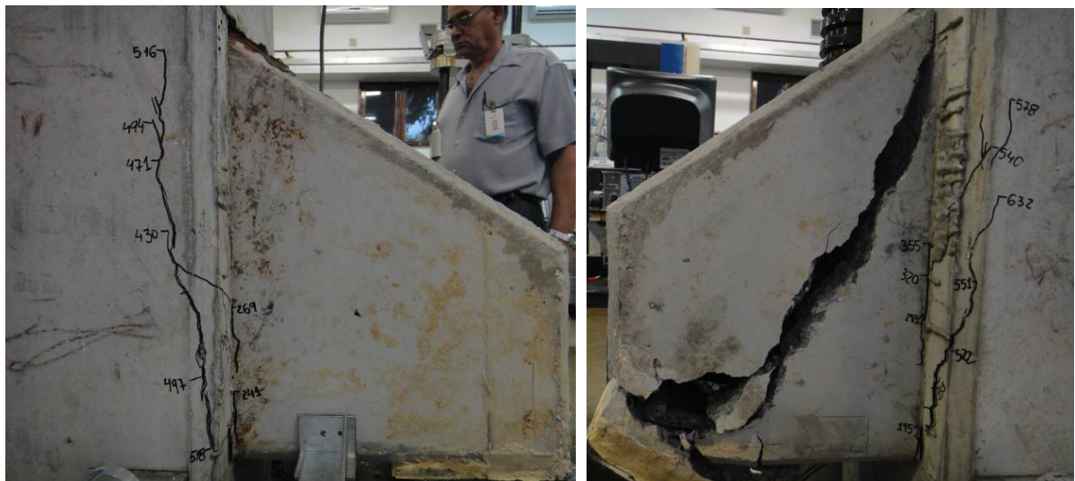
(c) Esmagamento da biela no consolo 1 ao final do ensaio
