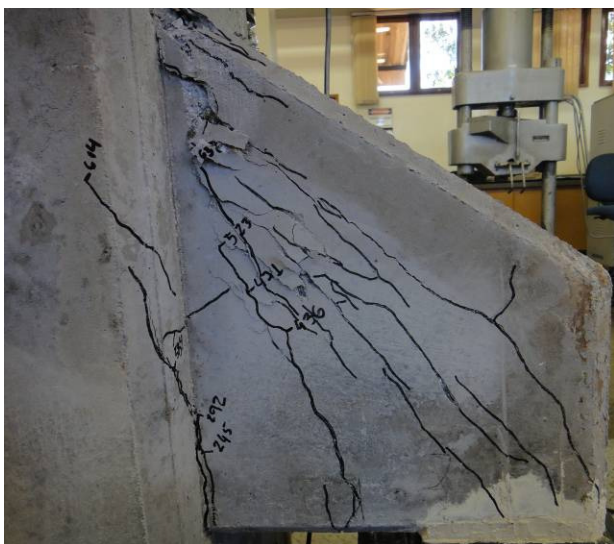
(c) Esmagamento da biela no consolo 1 ao final do ensaio
