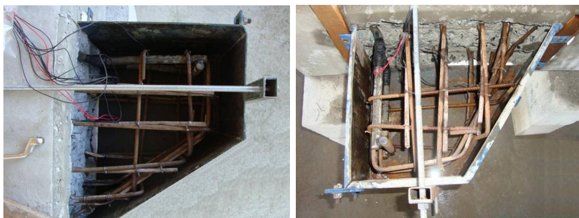
Figura 3.26 - Preparo dos consolos do modelo M9, com armadura dobrada.
