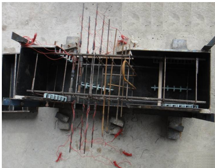
Figura 3.10 - Armadura do modelo M7 posicionada na fôrma, antes da concretagem do pilar, com a armadura de costura para fora da fôrma.
