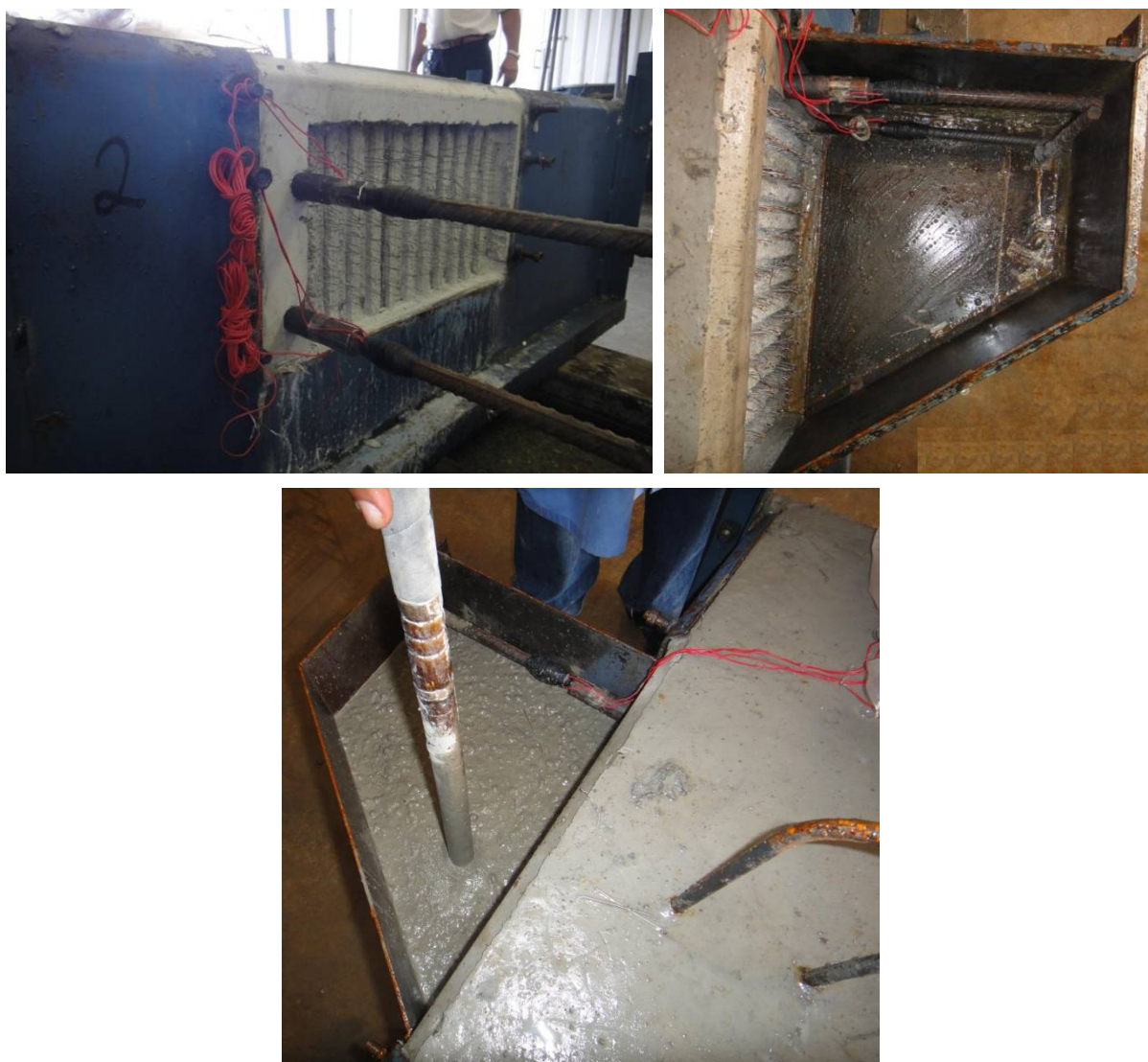
Figura 3.25 - Preparo e moldagem dos consolos do modelo M8, com fibras atravessando a interface.
