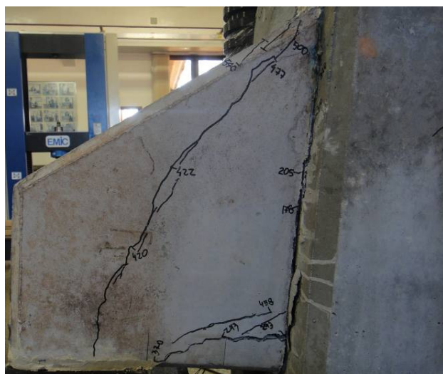
(d) Esmagamento da biela no consolo 2 ao final do ensaio
