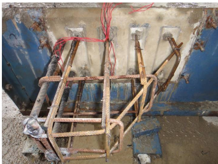
Figura 3.11 - Complemento da armadura de costura do consolo do modelo M4 deixada na concretagem do pilar.
