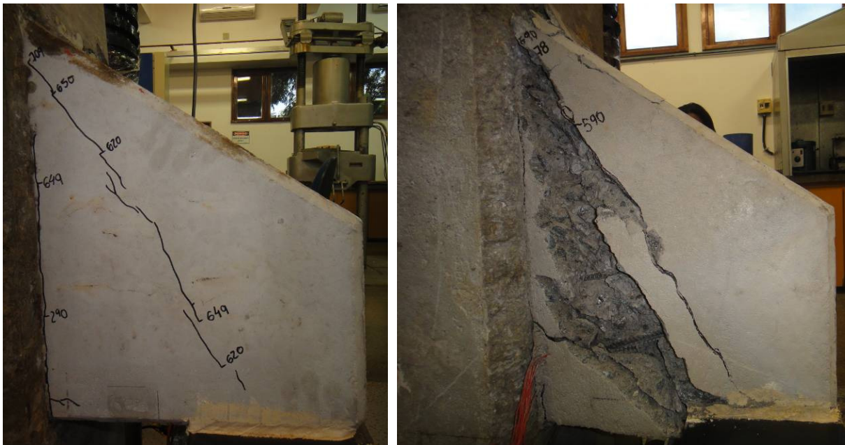
(c) Fissuração no consolo 1 ao final do ensaio
