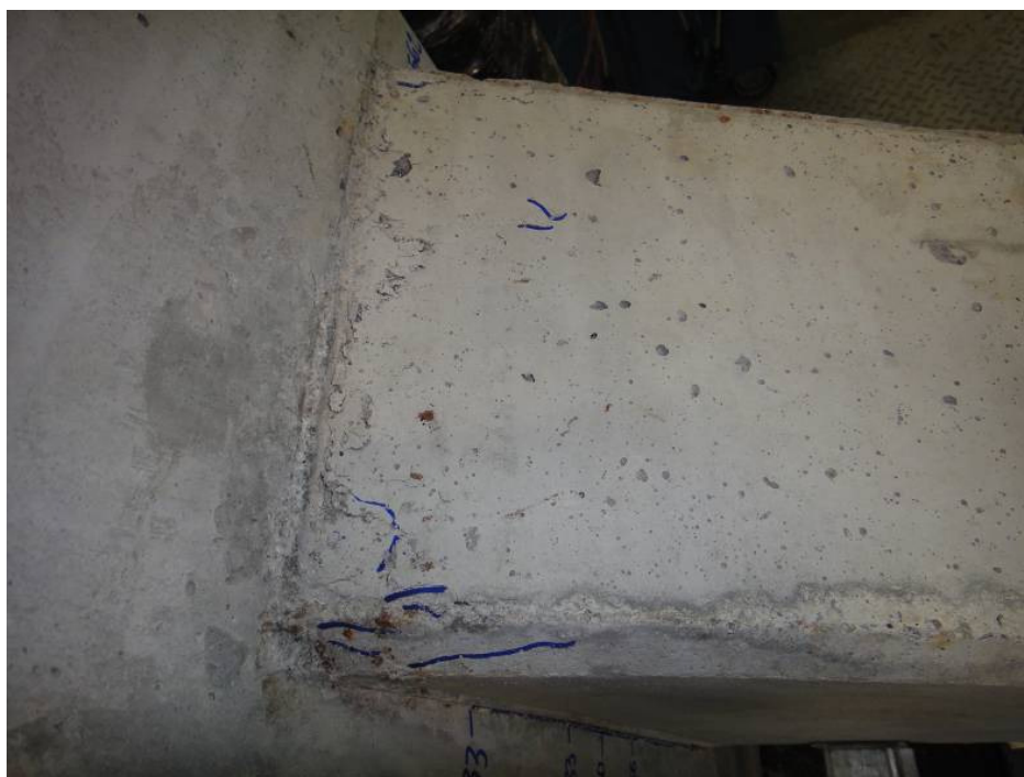
(c) Esmagamento do concreto no canto superior do consolo
