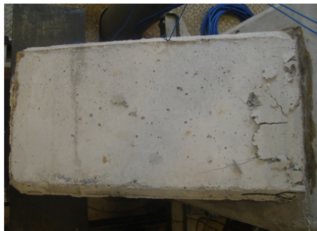
(c) Esmagamento do concreto no canto superior do consolo 1 ao final do ensaio
