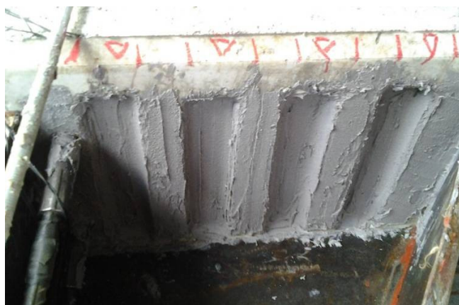
Figura 3.7 - Interface pilar-consolo com as chaves de cisalhamento no modelo M5, com o epóxi, antes da concretagem do consolo.
