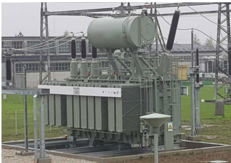
Figura 2.5 – Reator Shunt com núcleo de ferro imerso em óleo.
