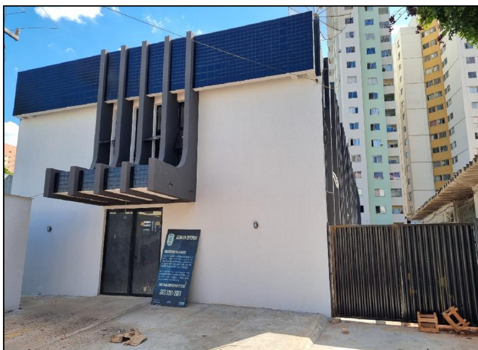
Figura 23 – Execução de reforma e ampliação das instalações da 1ª DEAM de Goiânia em 2024
