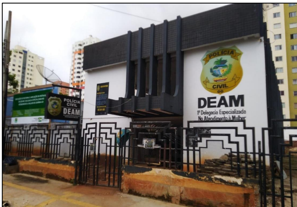
Figura 22 – Execução de reforma e ampliação das instalações da 1ª DEAM de Goiânia em 2023
