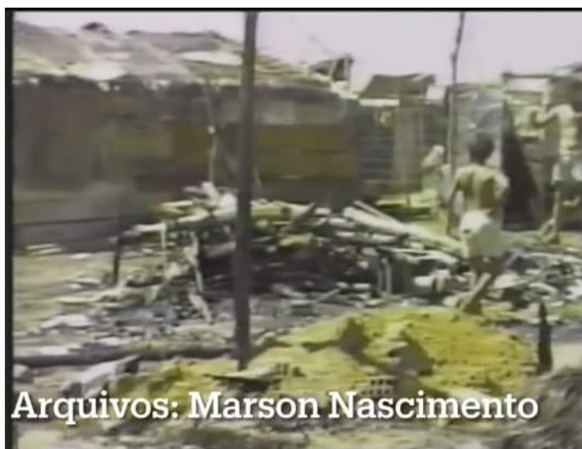
Figura 21 – Incêndio na invasão da cascalheira
