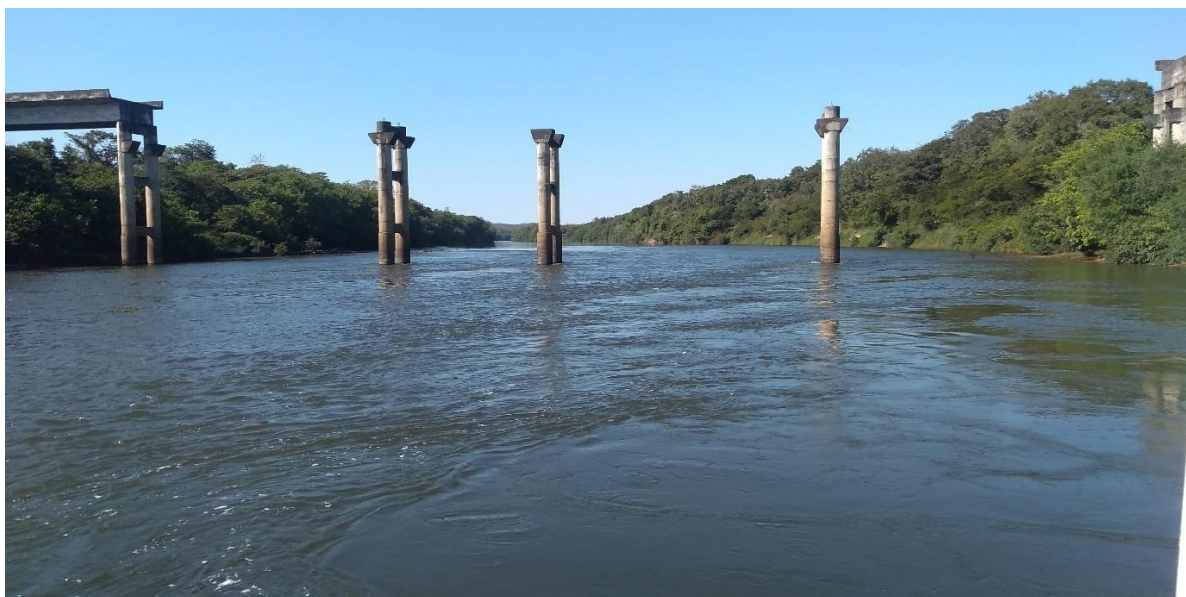
Figura 14 – Ponte sobre o Rio Sono – TO. 2021
