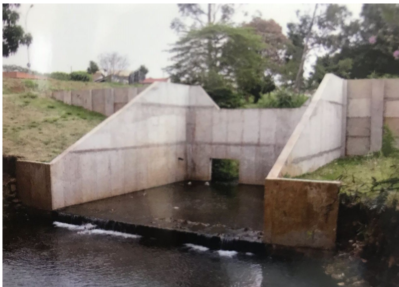
Figura 1.1 – Exemplo de obra de arte para controle de impactos à jusante.
