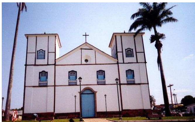
Figura 27: vista frontal em contra plongée da Matriz de Nossa Senhora do Rosário em Pirenópolis.
