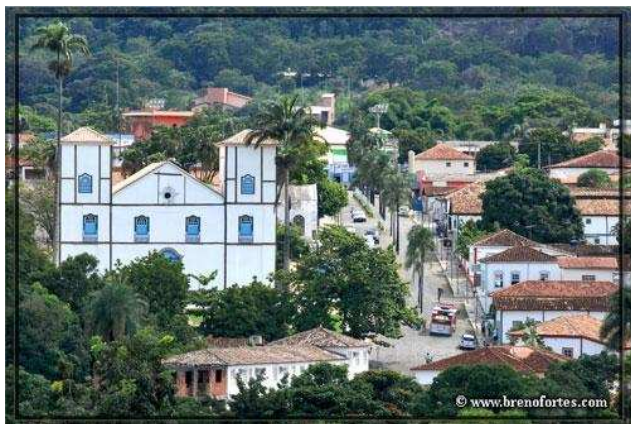
Figura 26: vista parcial da cidade de Pirenópolis destacando a Igreja do Rosário.
