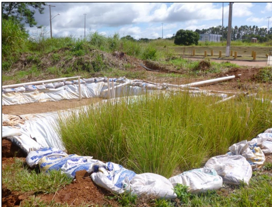
Figura 24: Plantas de capim Vetiver adaptadas ao tanque de tratamento.
