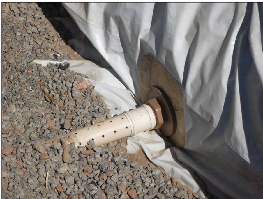
Figura 19: Detalhe da vedação da lona na saída dos tanques.
