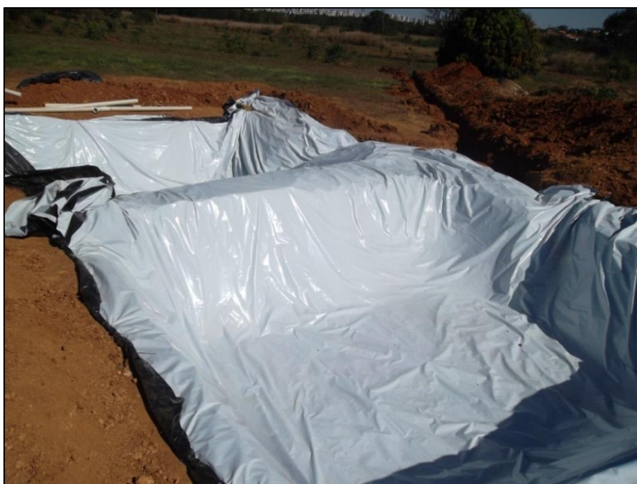
Figura 17: Detalhe do posicionamento da lona de impermeabilização nos tanques.
