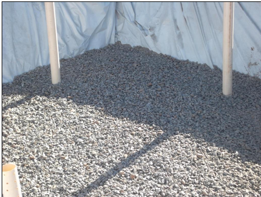
Figura 20: Preenchimento do fundo do leito de tratamento com brita nº 1.
