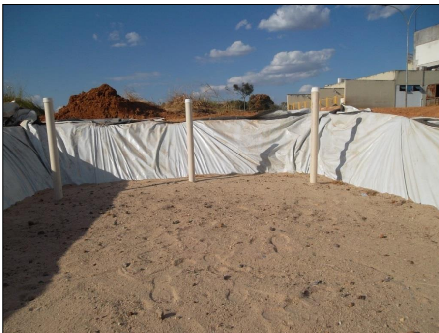
Figura 21: Preenchimento da superfície do leito de tratamento com areia média.
