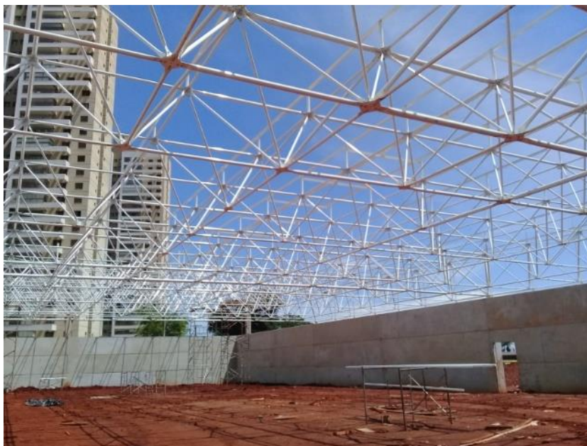
Figura 1.1-Cobertura em treliça de um supermercado em construção.
