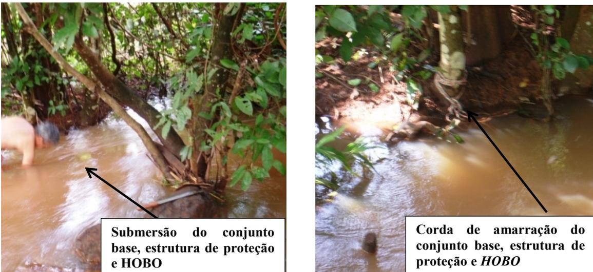
**Figura 5 – Assentamento do conjunto base, estrutura de proteção e *HOBOTest*, de forma discreta junto ao leito do córrego.**
