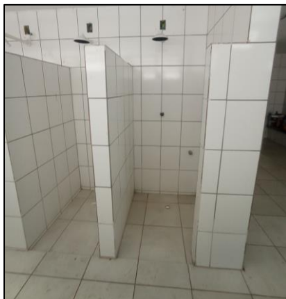
Figura 63 - Boxe com chuveiro no vestiário feminino
