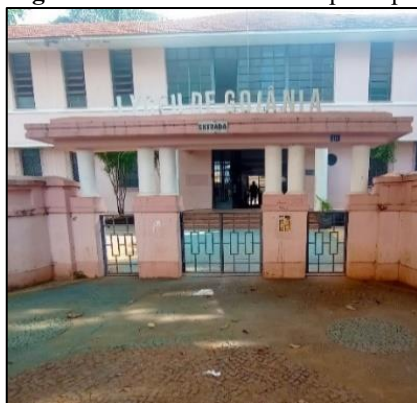
Figura 29 – Portão de acesso principal
