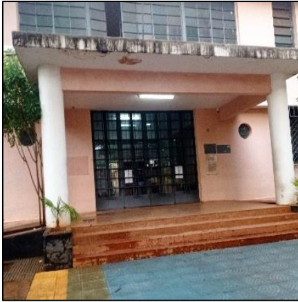
Figura 37 - Escada na entrada principal do bloco 1
