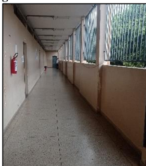
Figura 53 – Corredor do bloco 3
