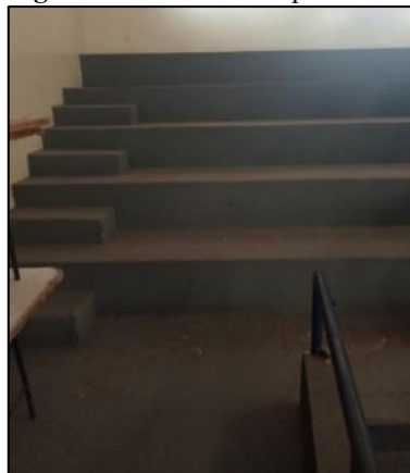
Figura 79 - Acesso à arquibancada
