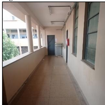
Figura 52 - Corredor do bloco 2
