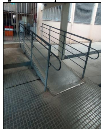
Figura 47 - Rampa do bloco 3
