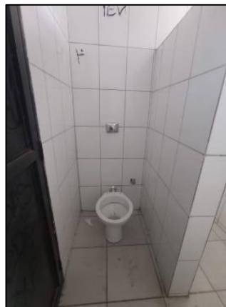
Figura 64 – Boxe com bacia sanitária no vestiário feminino
