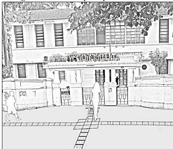
Figura 34 – Entrada principal com melhorias
