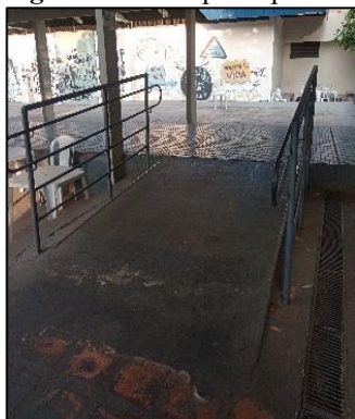
Figura 48 - Rampa da passarela
