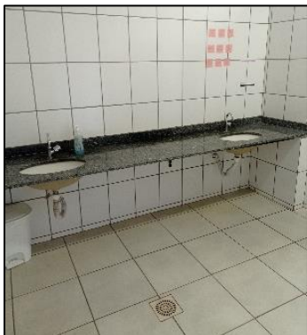
Figura 56 – Lavatório do sanitário coletivo
