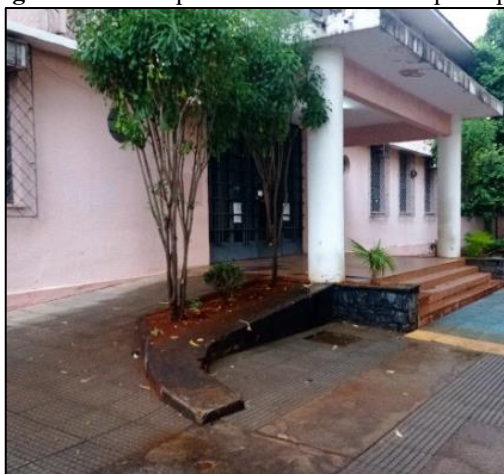
Figura 45 – Rampa na entrada do acesso principal
