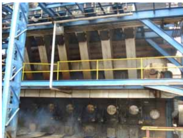
Figura 2.6 – Caldeira para queima do bagaço de cana-de-açúcar. Foto: Janaina F. Silva
