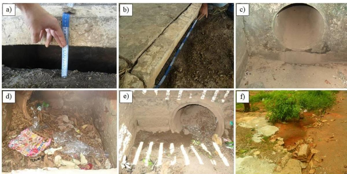
**Figura 10.** Elementos da microdrenagem avaliados *in loco*. Altura da entrada de água nas bocas de lobo (a); Comprimento da entrada de água nas bocas de lobo (b) Tubulação limpa (c); Tubulação suja (d); Tubulação entupida de sedimentos (e); Ausência de guias e sarjetas (f) Fonte: (Autor, 2019).
