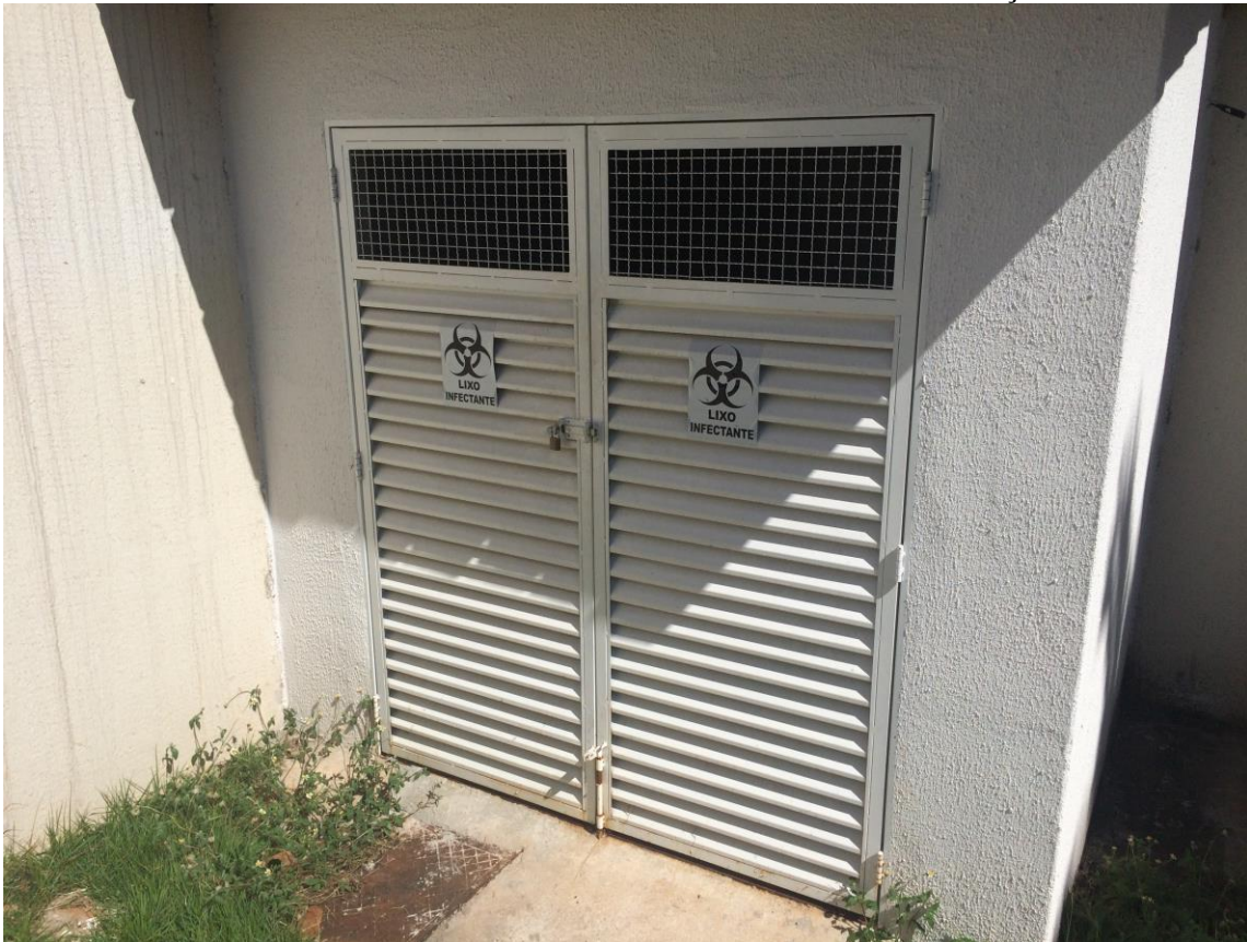
FIGURA 3 – Armazenamento externo de Resíduos de Serviço de Saúde
