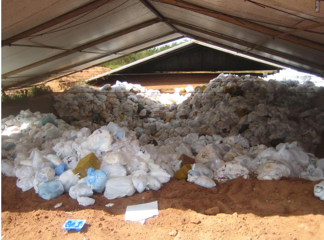
FIGURA 10 – Vala séptica preenchida com Resíduos de Serviço de Saúde. Aterro sanitário de Anápolis
