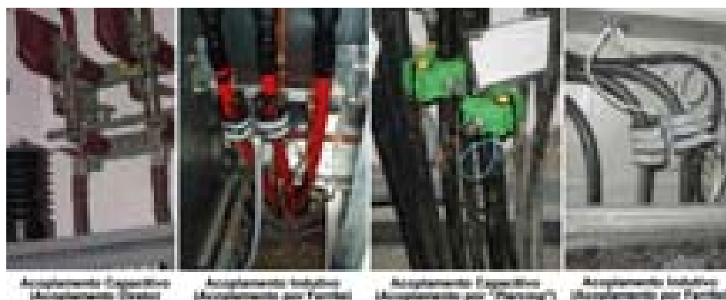
Figura 2.3 – Tipos de Acopladores PLC: Capacitivos e Indutivos [10]
