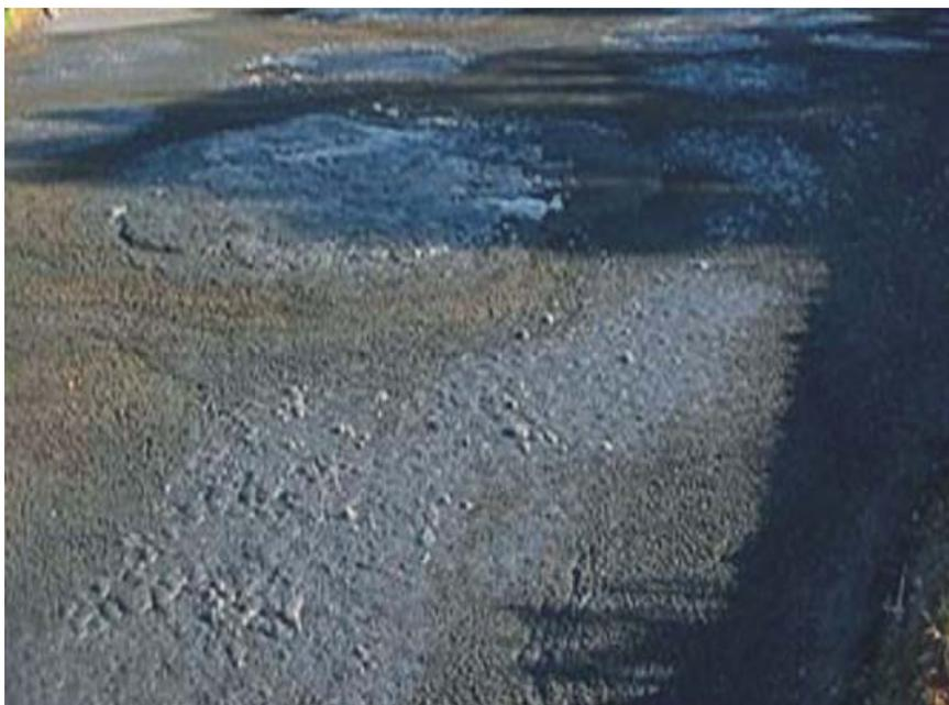
FIGURA 2.2 – Lagoa de decantação com formação de gás metano (bolhas) lançado diretamente na atmosfera.
