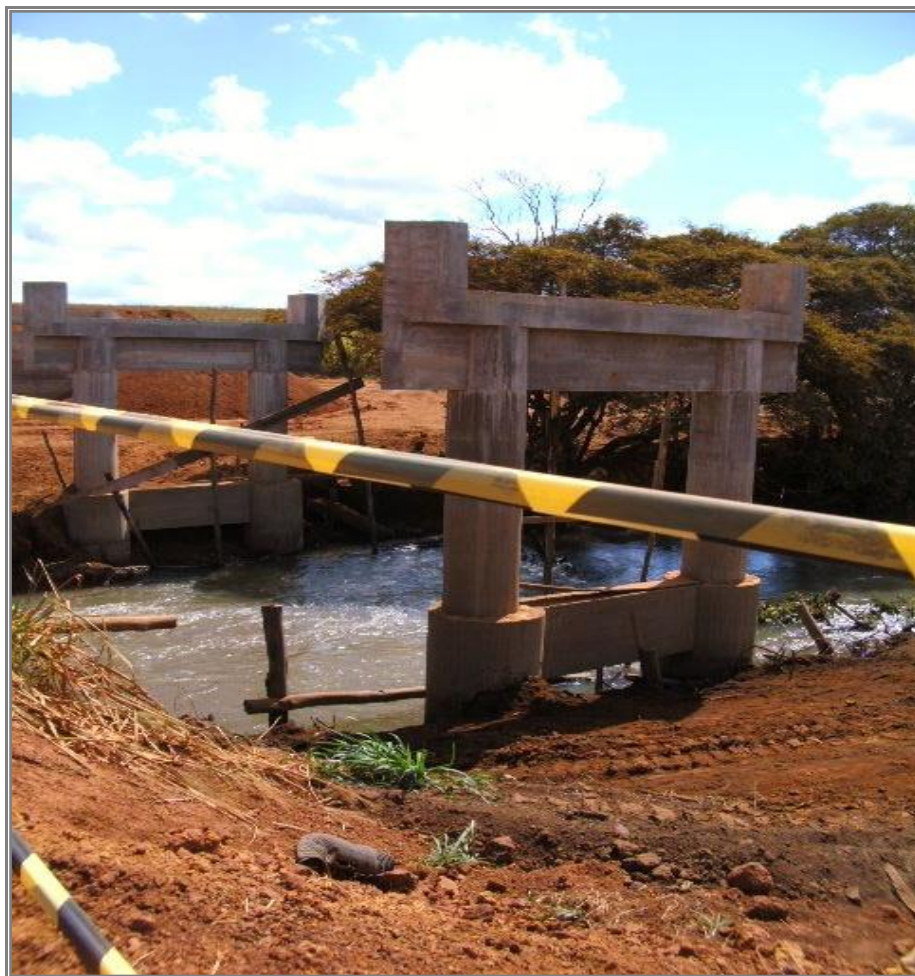
Figura 15 – Construção da Ponte Cosan, Jataí – GO. Fonte: OLIVEIRA, F. A. de. (2010)
