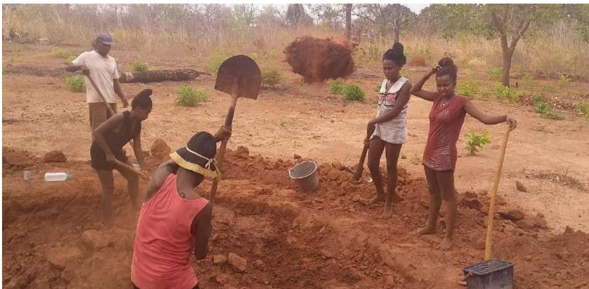
Figura 54. Construção das cisternas telhadão para captar água da chuva
