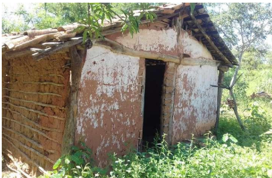
Figura 8. Casa de Varas
