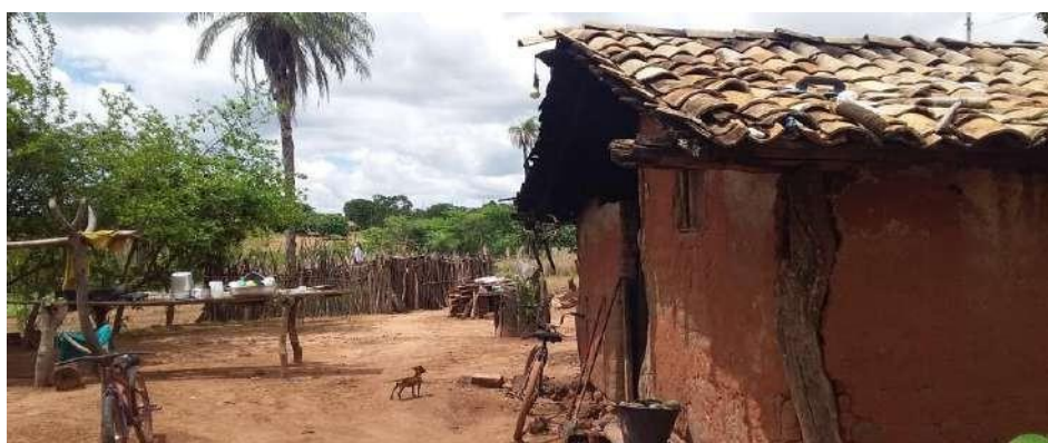
Figura7. Casa de enchimento
