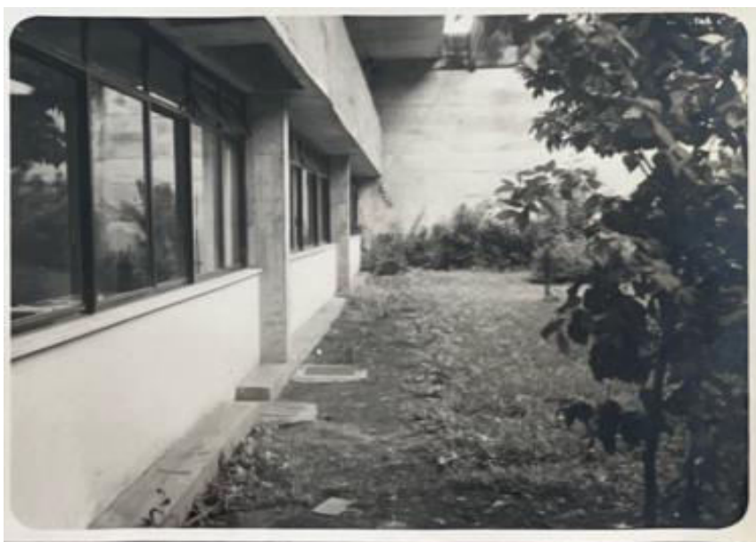
Fotografia 19 – Lateral direita pátio interno: Faculdade de Educação
