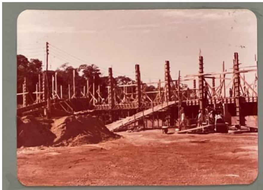
Fotografia 3 – Construção do Colégio Aplicação
