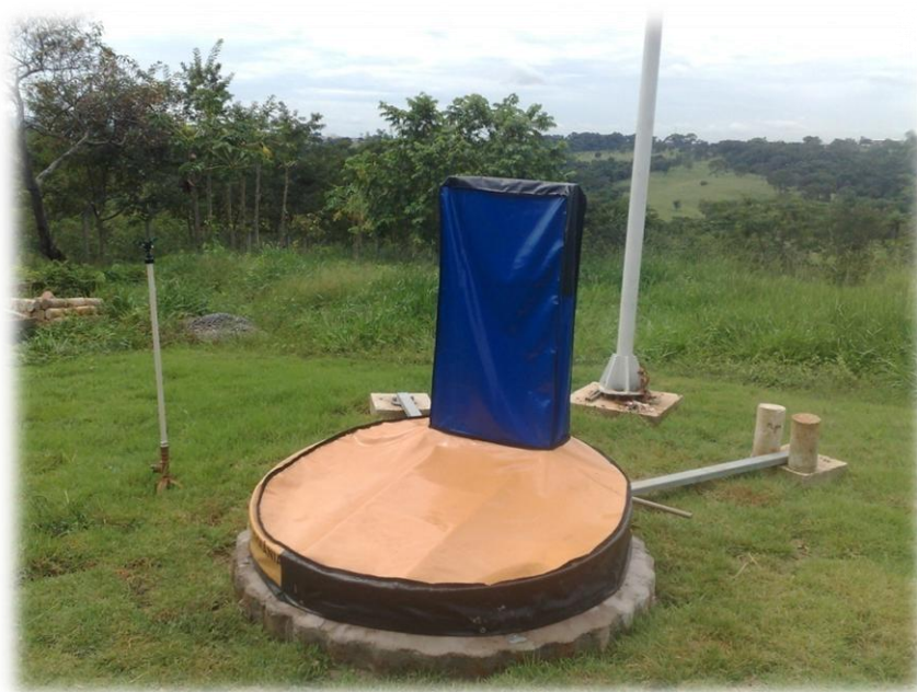
Figura 4.11: Poço de monitoramento
