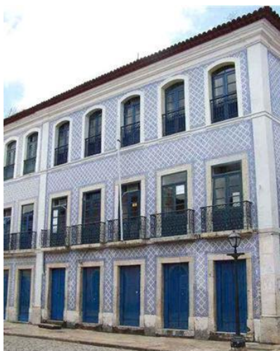
Figura 2. 3 – Fachada revestida de azulejos em São Luiz do Maranhão, Brasil (CERAMICANORIO, 2010).
