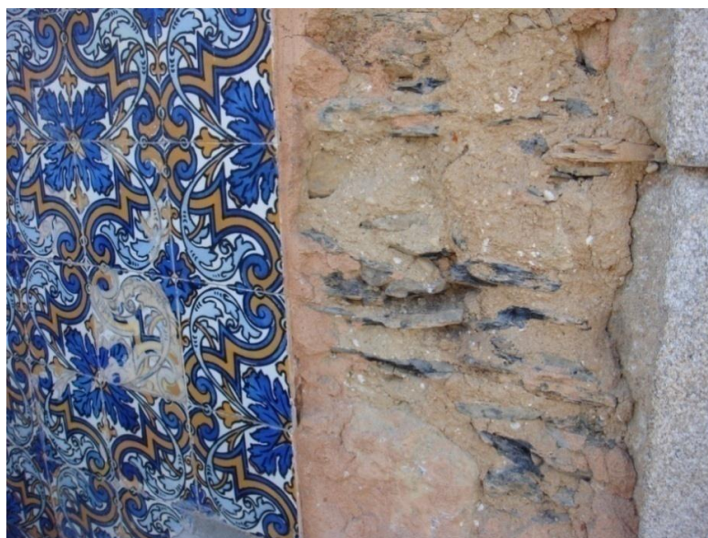
Figura 2. 4 – Exemplo de parede e revestimento cerâmico de fachada empregados em edificações na cidade de Ovar, Portugal (CARASEK; CASCUDO, 2010).
