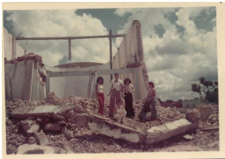
Imagem 63: Destruição de Igreja Nossa Senhora das Graças, para construção de uma nova.
