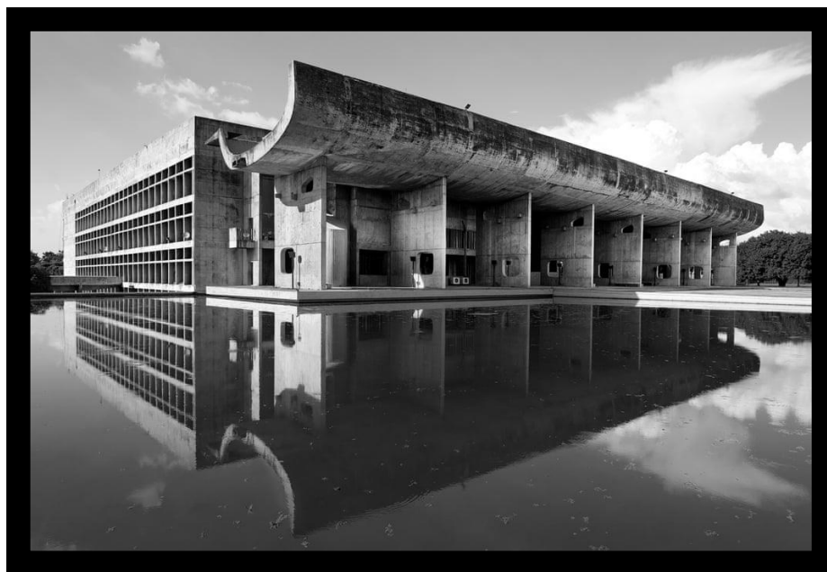
Figura 51 – Projeto de Le Corbusier para o Palácio da Assembleia (foto), o Palácio da Justiça e o Secretariado, erguidos entre 1953 e 1959, em Chandigarh 10 , Índia. A somatória entre função e forma gerando a estética, transformando o espaço arquitetônico e social. Fonte: https://www.theguardian.com/cities/gallery/2017/apr/07/the-city-le-corbusier-built-inside-chandigarh-in-pictures
