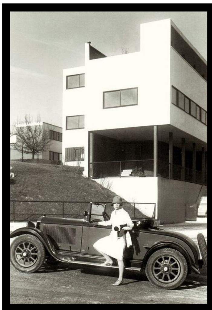
Figura 31 - A Casa Citrohan (1927), em Stuttgart, Alemanha. Projeto de Le Corbusier, na era do automóvel, do concreto e da “limpeza” na estética da arquitetura, representando o espírito da época. A função determina a forma, que por sua vez condiciona a estética final. A “simplificação” das formas decorre de um estudo sobre as formas, volumes e superfícies primordiais, nos quais ao ser humano reconhece (inconscientemente) tais configurações.
