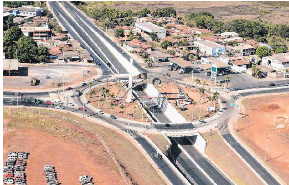
Saída Leste: duplicação e construção de modernos viadutos na interligação entre Goiânia e Senador Canedo, uma das mais movimentadas da Região Metropolitana
