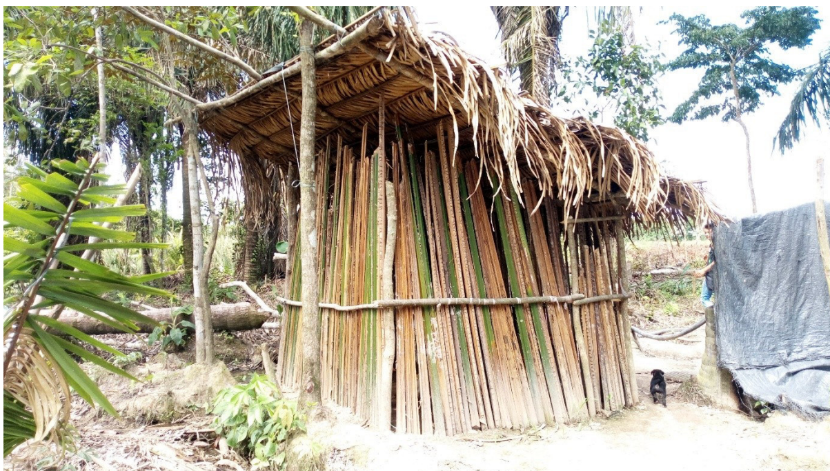
Figura 27. Casa feita de véu de palmeira para proteger as galinhas dos gúivos. Fonte: fotografia de Deisy Johanna Moreno, 2020.
