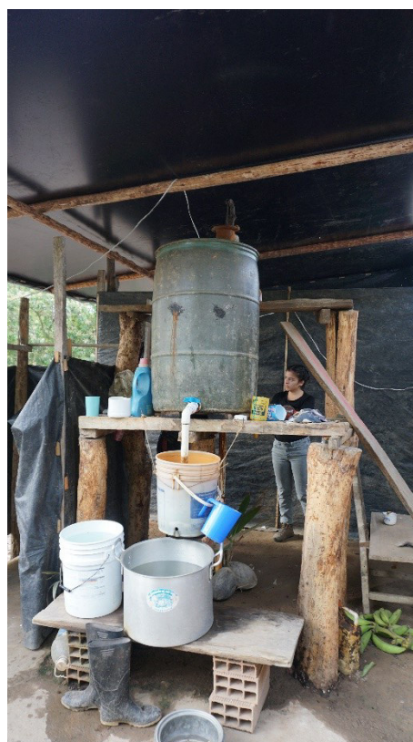
Figura 7: Puntillo com sistema de filtragem (Autor: Johanna Moreno, 2020)
