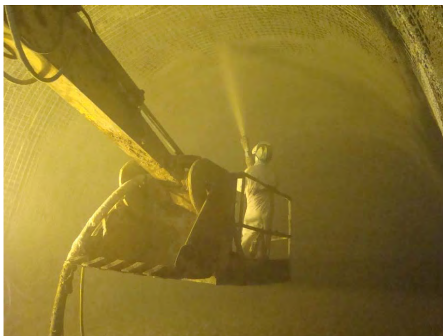
Figura 2.3 – Projeção do concreto – emboque sul – túnel 1 Utilização de gaiola de sustentação em escavadeira
