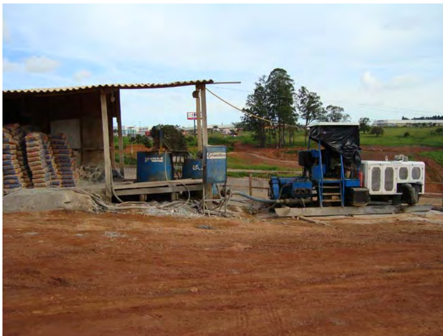
Figura 3.4 – Alimentação de cimento e agregados no emboque sul do túnel 2. Sistema via seca - Bomba injetora Sheikan Ancor Jet .
