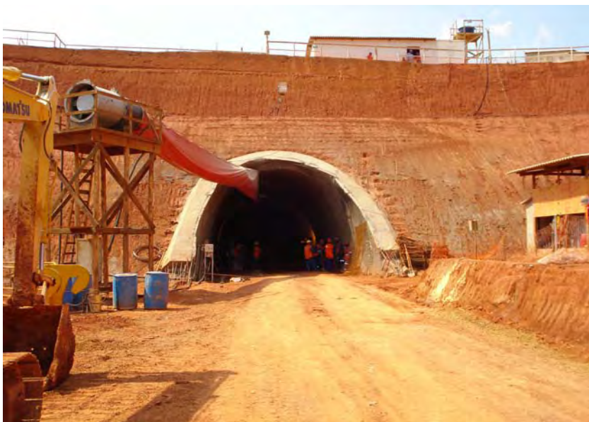
Figura 1.2 – Emboque norte túnel 1 ferrovia norte sul – trecho Anápolis - Porto Seco Novembro/2008
