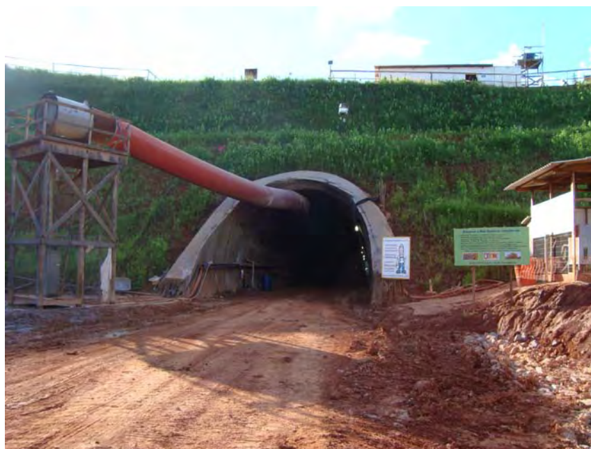
Figura B 2 – Emboque norte túnel 1 Ferrovia Norte Sul – trecho Anápolis - Porto Seco Abril/2009
