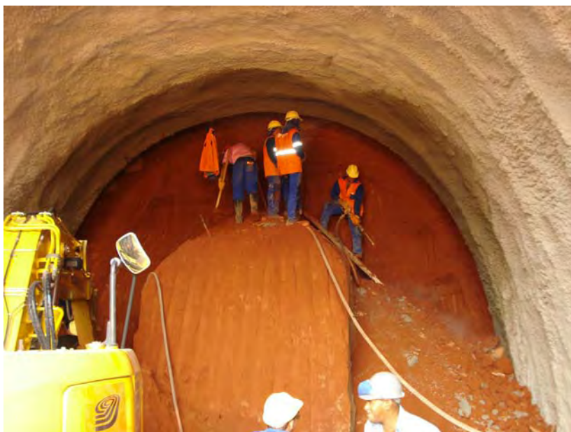
Figura 1.3 – Escavação túnel 1 ferrovia norte sul – trecho Anápolis Novembro/2008
