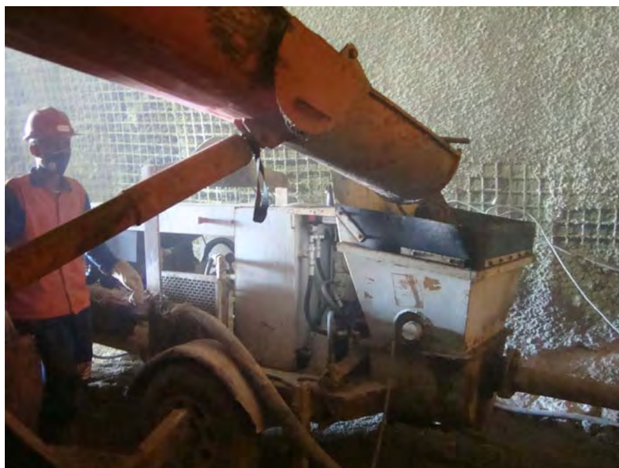
Figura 3.3 – Alimentação de concreto no emboque sul do túnel 1. Sistema via úmida - Bomba injetora Schwing .
