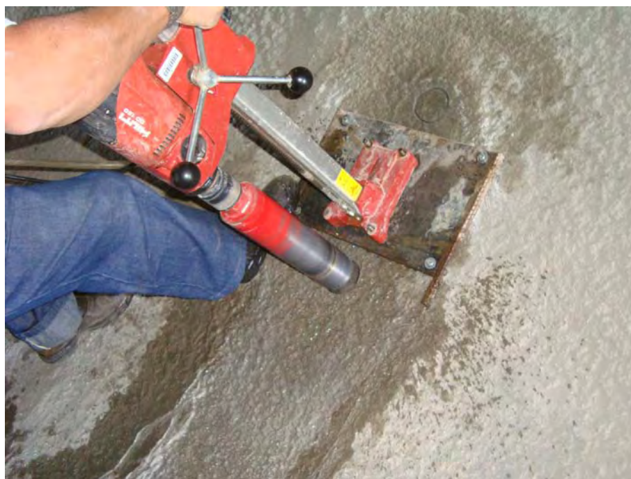
Figura 3.10 – Extração de testemunho na estrutura do túnel 01 – emboque norte. Placa aparafusada na base do equipamento e no túnel – lado de baixo (inversão da placa da base).
