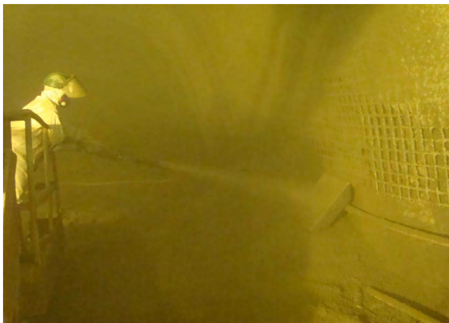
Figura 2.2 – Projeção em placas no túnel 01 – emboque sul – sistema via seca
