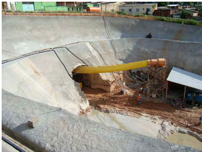
Figura B 3 – Emboque sul túnel 1 ferrovia norte sul – trecho Anápolis - Porto Seco Abril/2009
