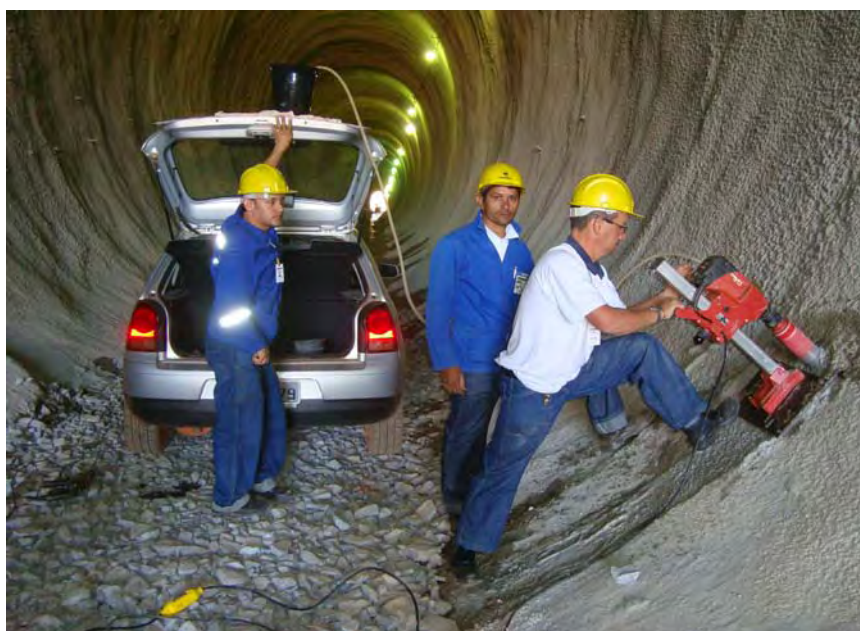
Figura 3.8 – Extração de testemunho na estrutura do túnel 01 – emboque norte. Detalhe da colocação de balde acima do nível da extratora.
