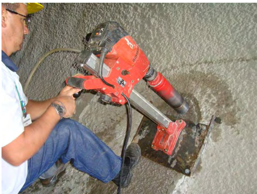
Figura 3.9 – Extração de testemunho na estrutura do túnel 01 – emboque norte. Placa aparafusada na base do equipamento e no túnel – lado de cima.
