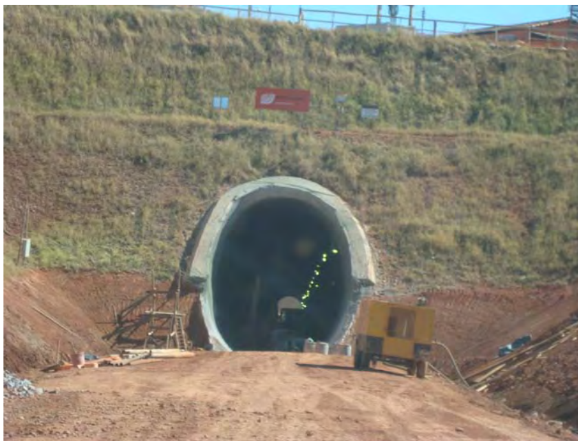
Figura 1.4 – Emboque norte túnel 1 ferrovia norte sul – trecho Anápolis - Porto Seco Agosto/2009
