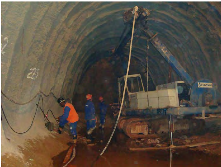
Figura B 7 – Emboque norte túnel 1 Ferrovia Norte sul – trecho Anápolis - Porto Seco Abril/2009 – colocação de enfilagens
