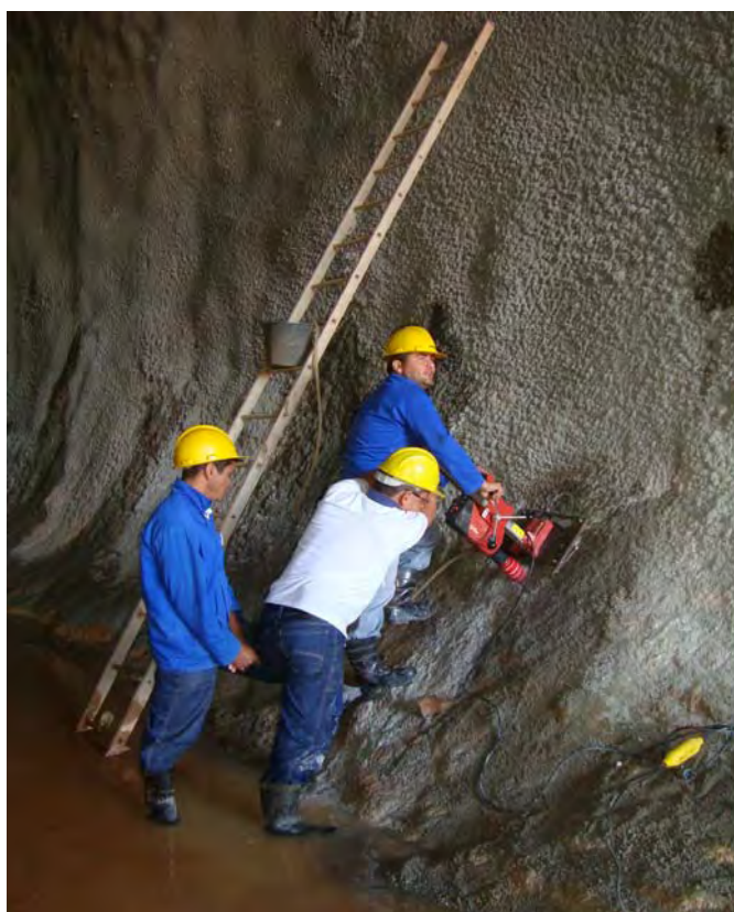
Figura 3.12 – Extração de testemunho na estrutura do túnel 01 – emboque sul. Placa aparafusada na base do equipamento e no túnel – lado de baixo – detalhe balde.
