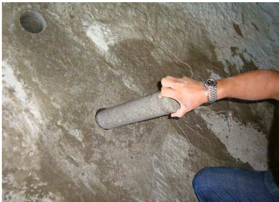
Figura 3.11 – Extração de testemunho na estrutura do túnel 01 – emboque norte. Retirada do corpo-de-prova – lado de baixo – detalhe arame amarrado facilita remoção.
