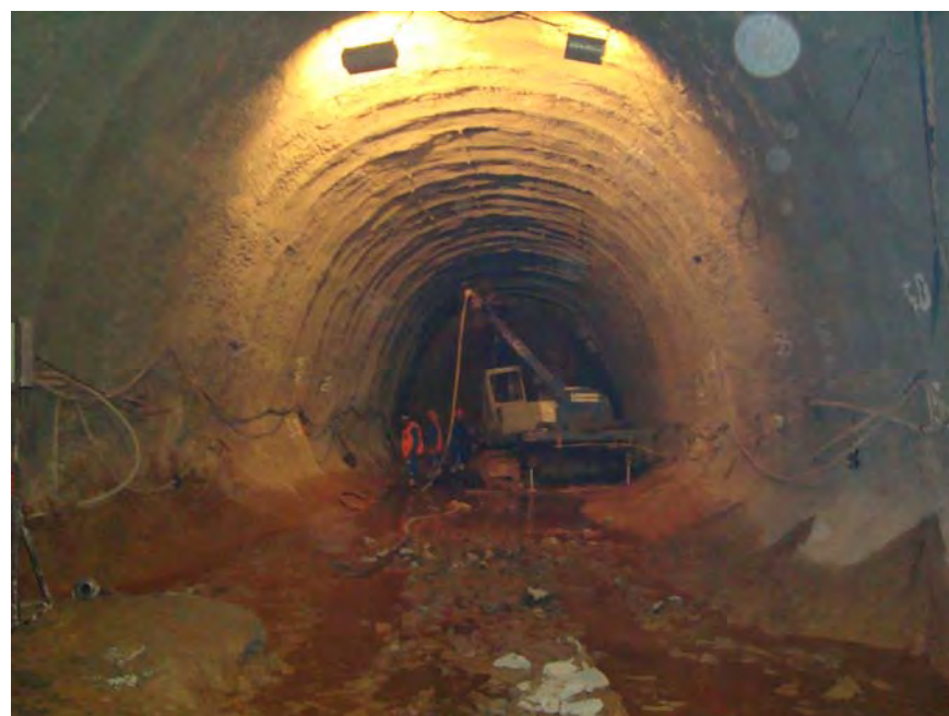
Figura B 6 – Emboque norte túnel 1 ferrovia norte sul – trecho Anápolis - Porto Seco Abril/2009
