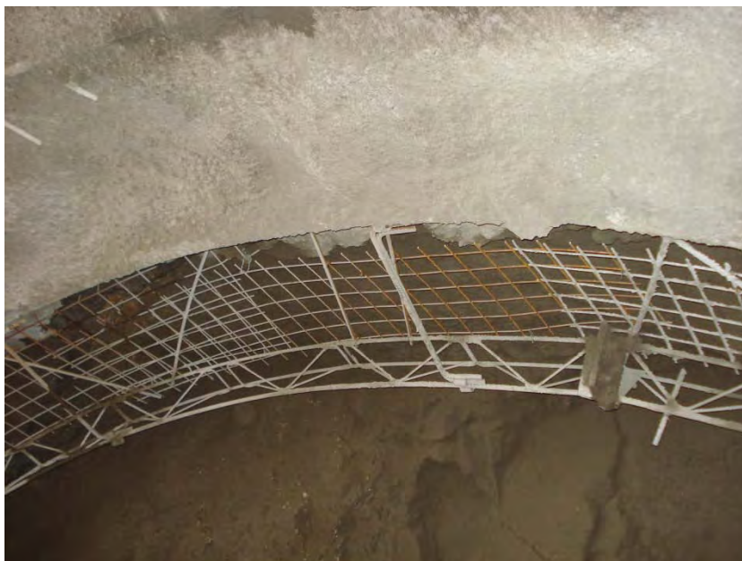
Figura 2.4 – Detalhe da cambota – armadura - túnel 01 ferrovia norte sul – trecho Anápolis - Porto Seco.
