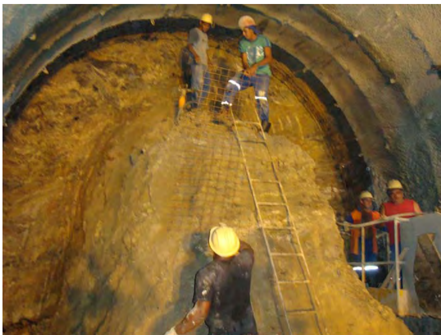
Figura B 8 – Emboque norte túnel 2 Ferrovia Norte sul – trecho Anápolis - Porto Seco Abril/2009 – colocação de telas no túnel
