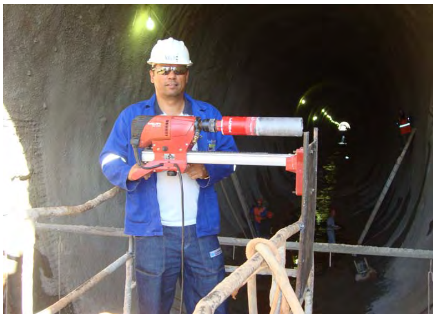
Figura B 4 – Instalação da extratora na gaiola da escavadeira (tentativa de extração no túnel 1).
