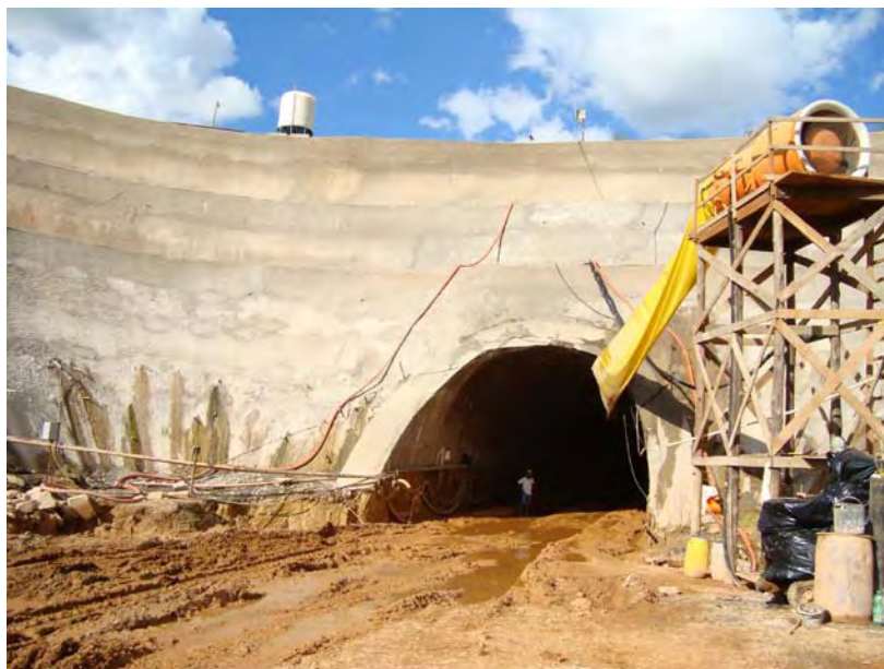
Figura B 1 – Emboque sul túnel 2 Ferrovia Norte Sul – trecho Anápolis - Porto Seco Abril/2009
