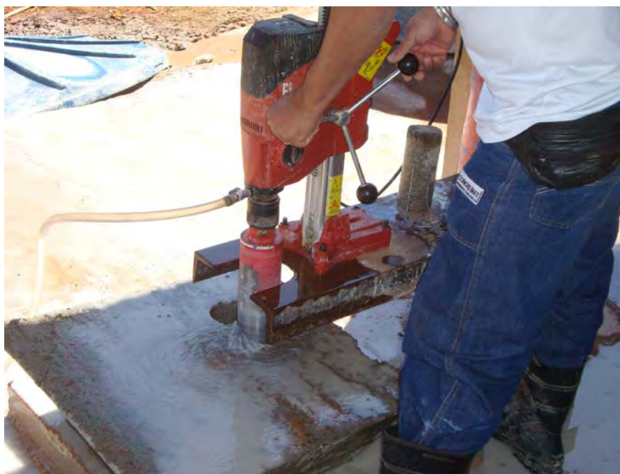
Figura 3.5 – Extração de corpos-de-prova da placa. Local: canteiro de obra da Queiroz Galvão Construtora S.A.
