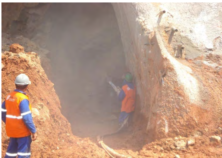
Figura 2.1 – Projeção no túnel 1 Ferrovia Norte-Sul – trecho Anápolis - Porto Seco.
