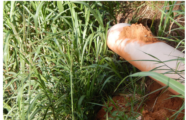
Figura 78 - Ponto de lançamento de efluente. Bacia do córrego Almeida. Fonte: Fotografia de Belizario, W. (2015)
