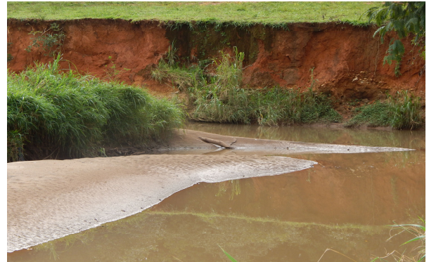
Figura 58 - Assoreamento. Bacia do córrego Santa Rita Fonte: Fotografia de Belizario, W. (2015)
