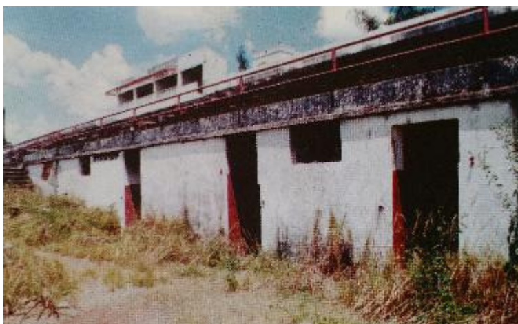
Figura 38: Arquibancada destruída em 2003. Fonte: TELES, 2005.
