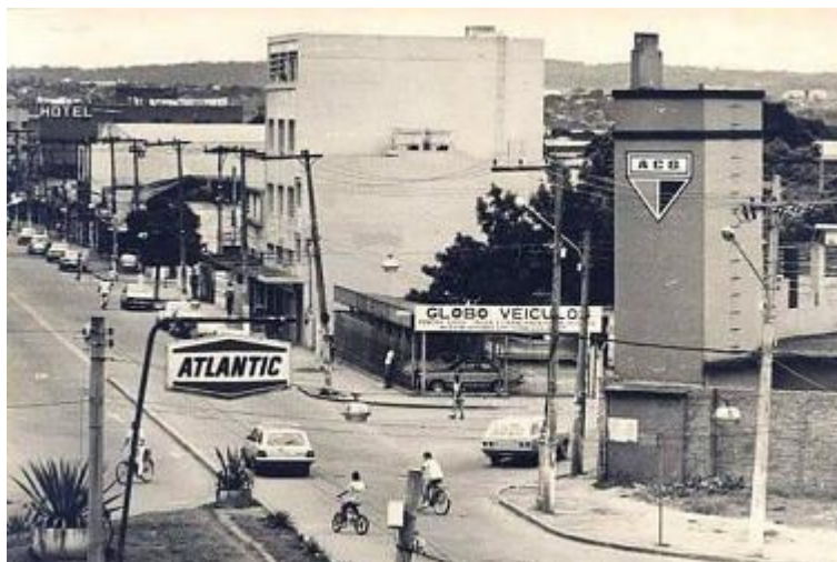
Figura 35: Fachada do Estádio Antônio Accioly por volta de 1970. Fonte: Autor desconhecido, 2018.
