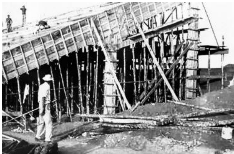
Figura 33: Construção da arquibancada do Estádio Antônio Accioly em 1958. Fonte: OLIVEIRA, 2018.
