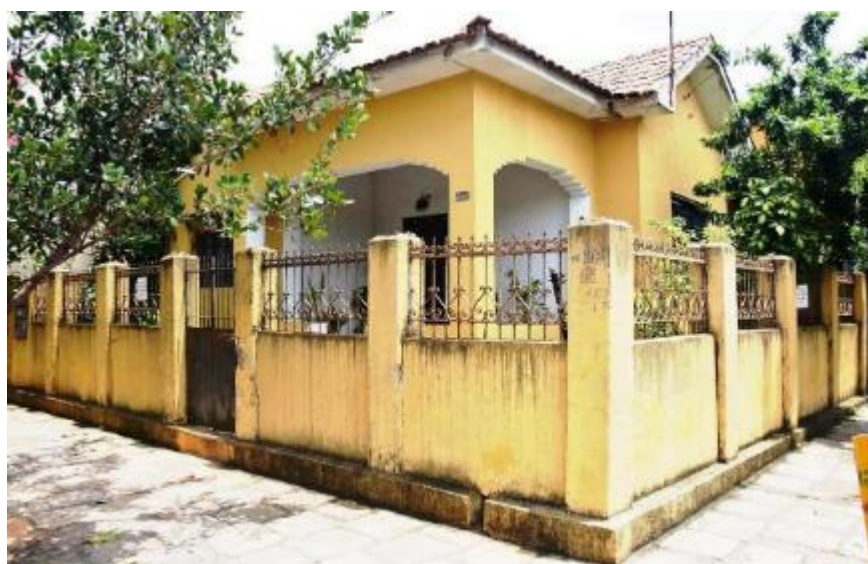
Figura 12: Casa com alpendre na Rua Santa Luzia. Fonte: Arquivo da autora 2017.
