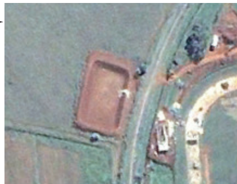
Figura 4A: Bacia de retenção/infiltração.
