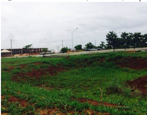
Figura 2A: Bacia de retenção/infiltração.
