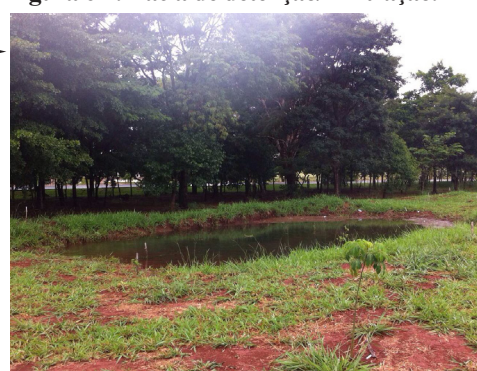
Figura 6A: Bacia de retenção/infiltração.
