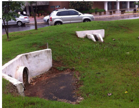
Figura 5A: Bacia de retenção/infiltração.
