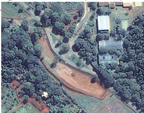
Figura 1A: Bacia de retenção/infiltração.
