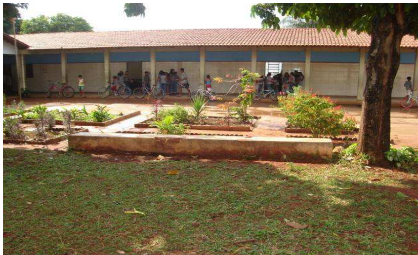
Figura 9: Colégio Estadual Padre Alexandre de Moraes Fonte: acervo particular Daiane Tonaco
