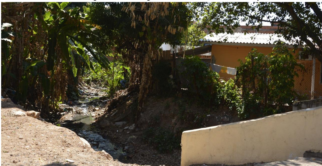
Foto 19 – Moradia irregular no Córrego do Barbado, no Bairro Canjica, em Cuiabá
