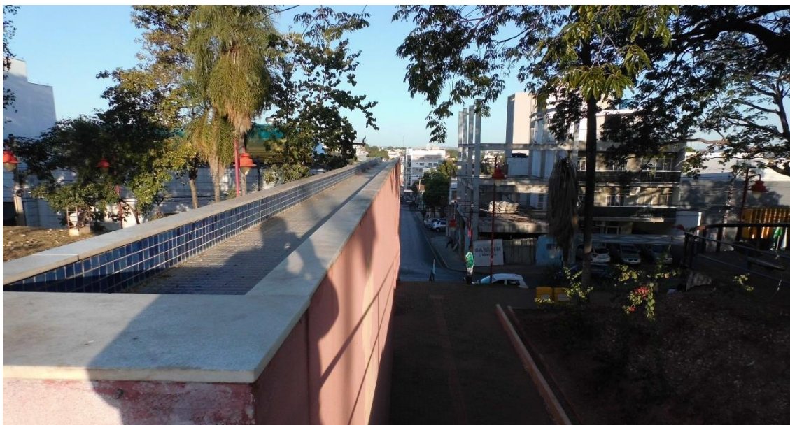
Foto 16 – Morro da Caixa D'Água Velha, face voltada para a Avenida da Prainha, em Cuiabá
