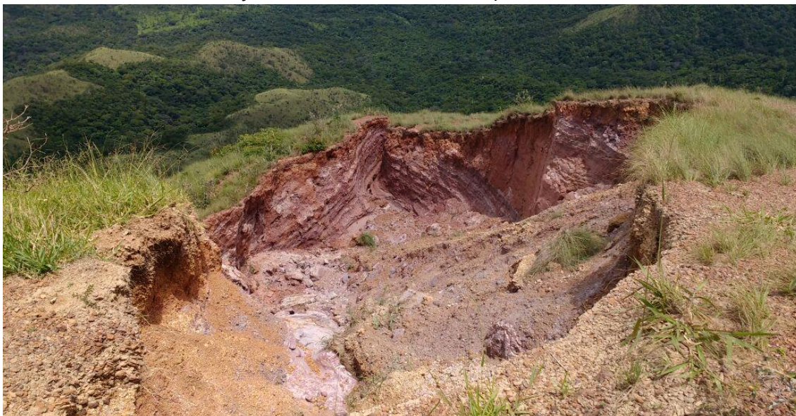
Foto 15 – Voçoroca, no Mirante, em Chapada dos Guimarães
