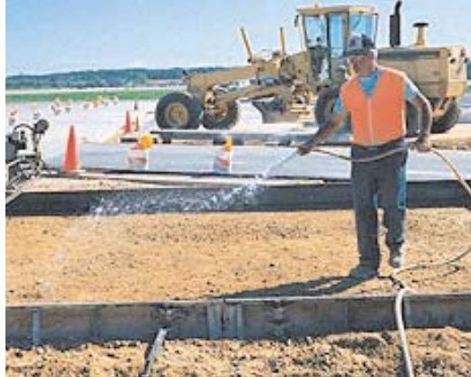
Figura 2.10 – Preparação da sub-base para recebimento do concreto fresco (KOSMATKA; KERKHOFF; PANARESE, 2003).
