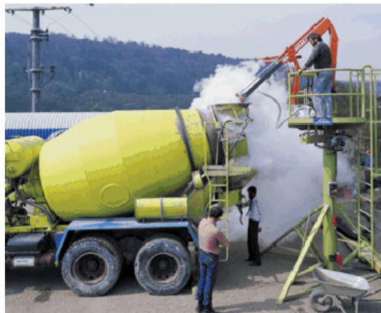
Figura 2.17 – Nitrogênio líquido sendo adicionado diretamente dentro do caminhão betoneira (FREITAS JUNIOR, 2013).
