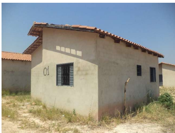
Figura 3.10 – Registro fotográfico da UH com o revestimento de argamassa externo e esquadria metálica executados
