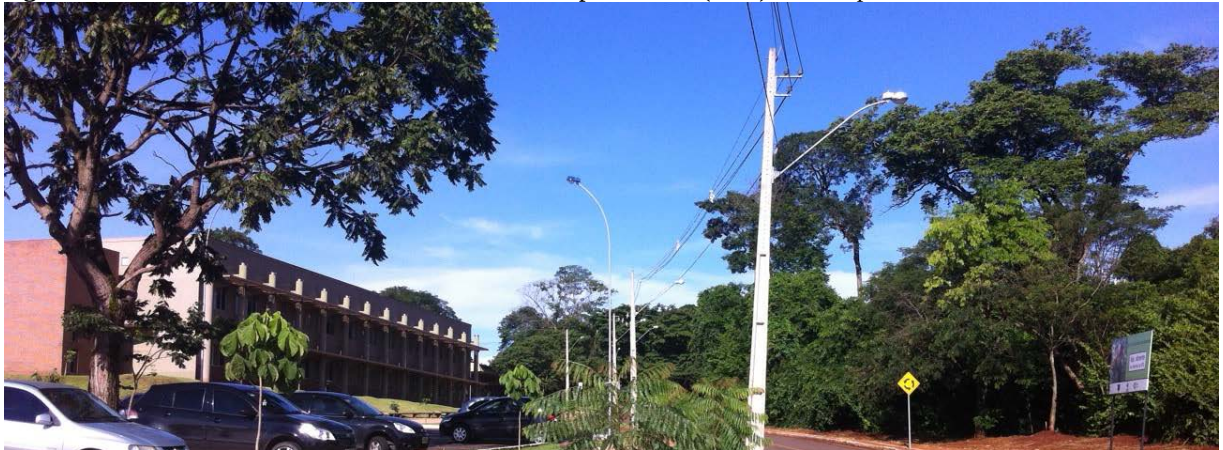
Figura 39. Edifício executado em 2012 e mata nativa preservada (APP) no Campus Samambaia , UFG.
