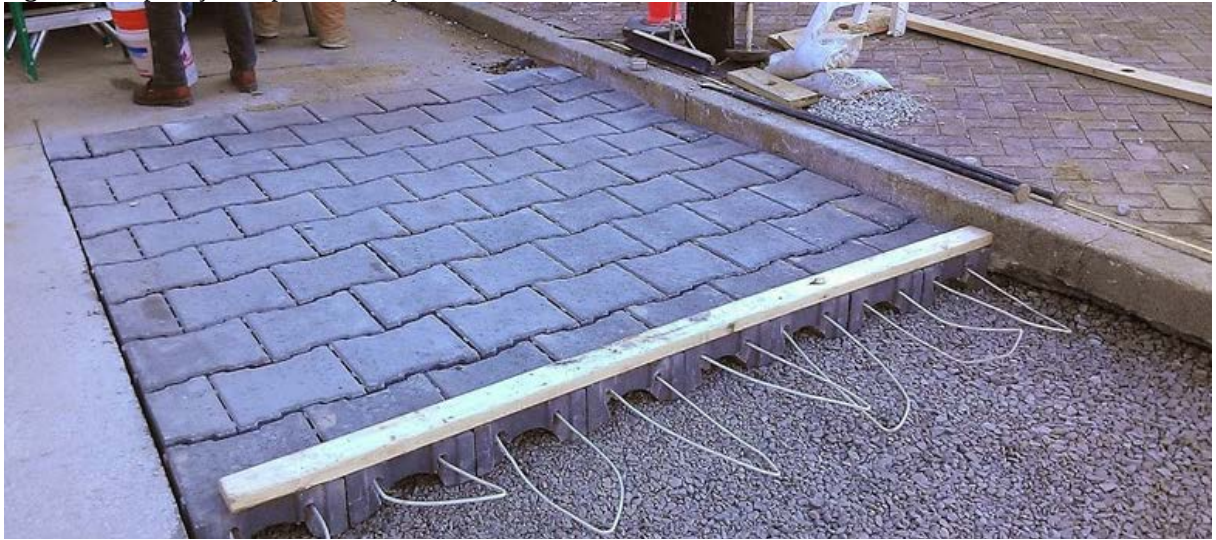
Figura 18. Aplicação de pavimento permeável.
