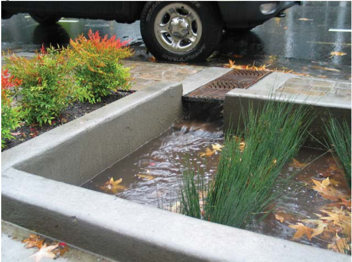
Figura 16. Jardim de chuva com corte no meio fio.
