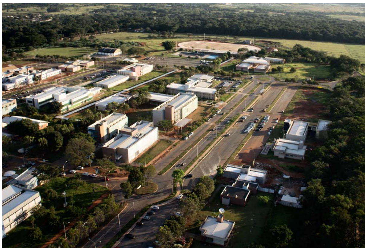
Figura 74. Vista aérea do anel viário do Campus Samambaia , UFG, sentido oeste.
