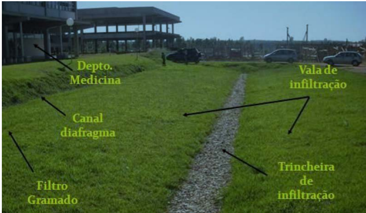
Figura 32. Sistema filtro-vala-trincheira implantado no Campus São Carlos, UFSCar .
