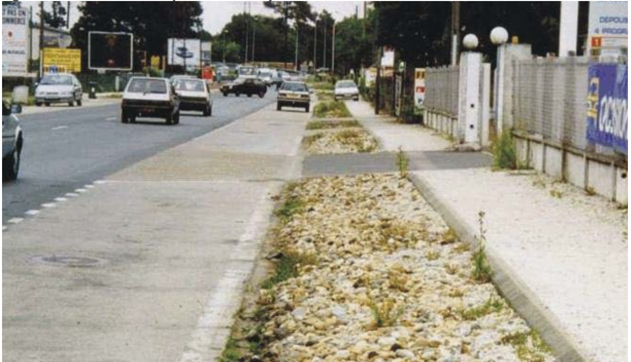
Figura 9. Trincheira de infiltração com alimentação direta.
