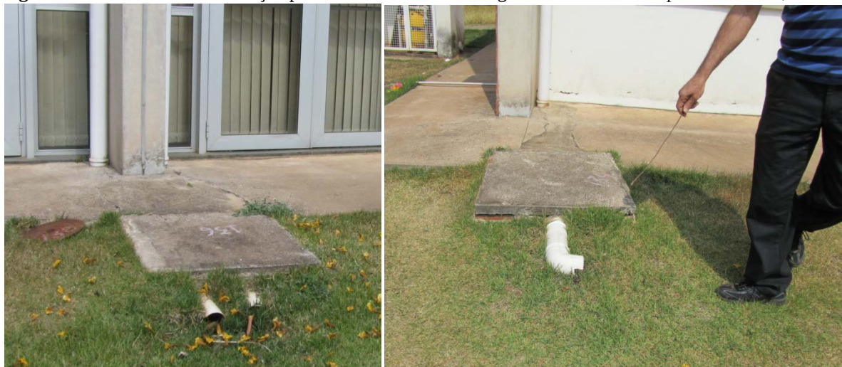
Figura 31. Desconexão da tubulação pluvial do sistema de drenagem existente no Campus São Carlos, UFSCar .
