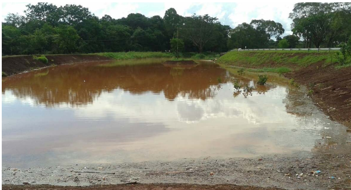
Figura 63. Bacia de retenção no Campus Samambaia , UFG, localizada perto do Centro de Ensino e Pesquisa Aplicada à Educação.
