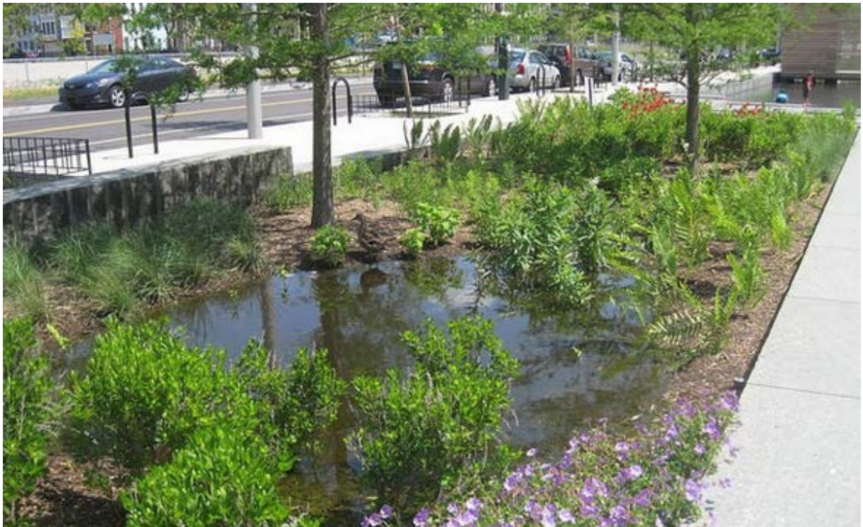
Figura 14. Jardim de chuva com retenção de água.
