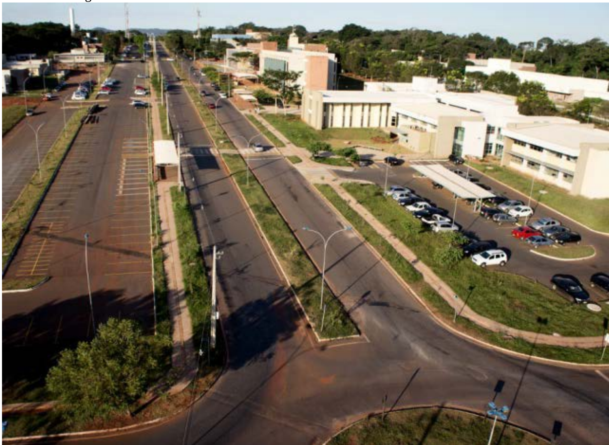
Figura 76. Vista aérea do anel viário do Campus Samambaia , UFG, evidenciando a duplicação de vias, as rotatórias em lugar de cruzamentos e extensas áreas de estacionamento.
