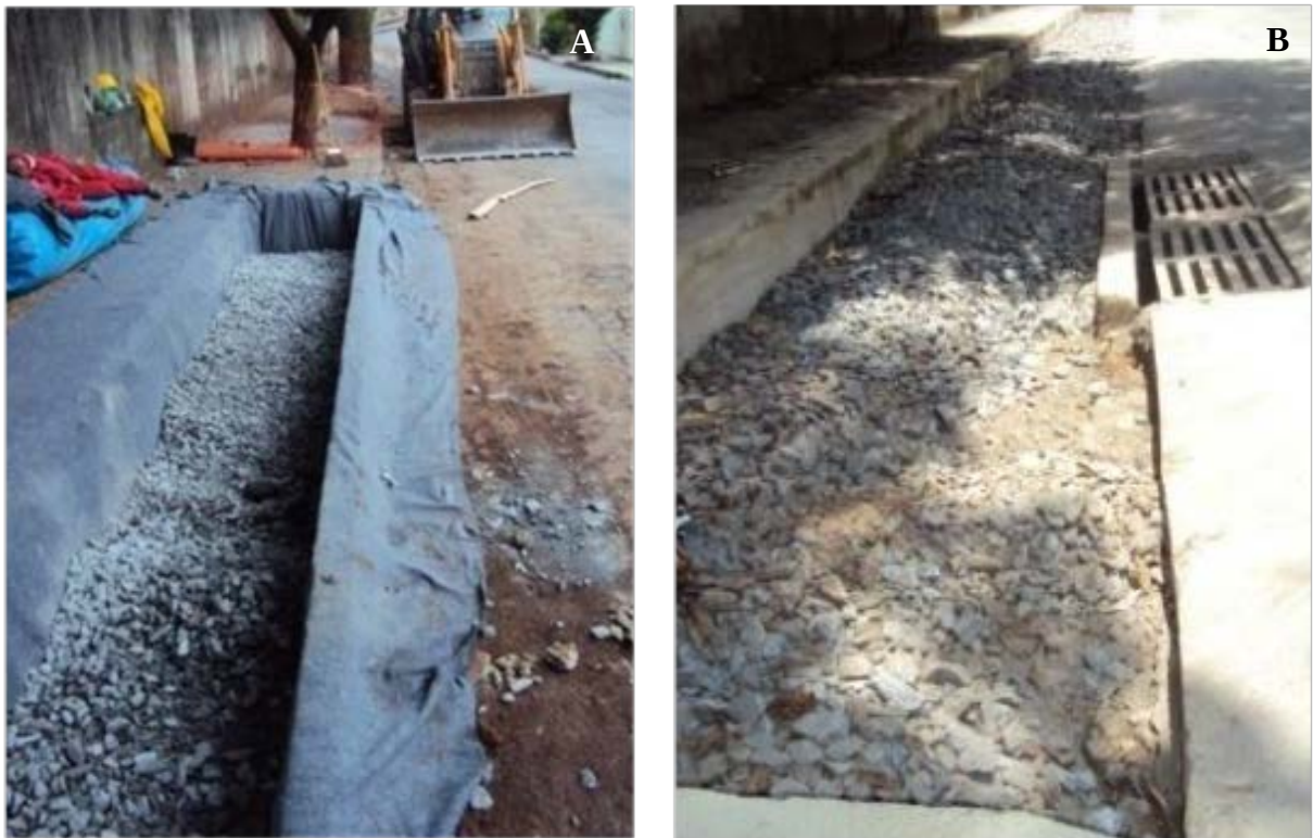
Figura 10. Trincheira implantada em Belo Horizonte pela SUDECAP-MG.
