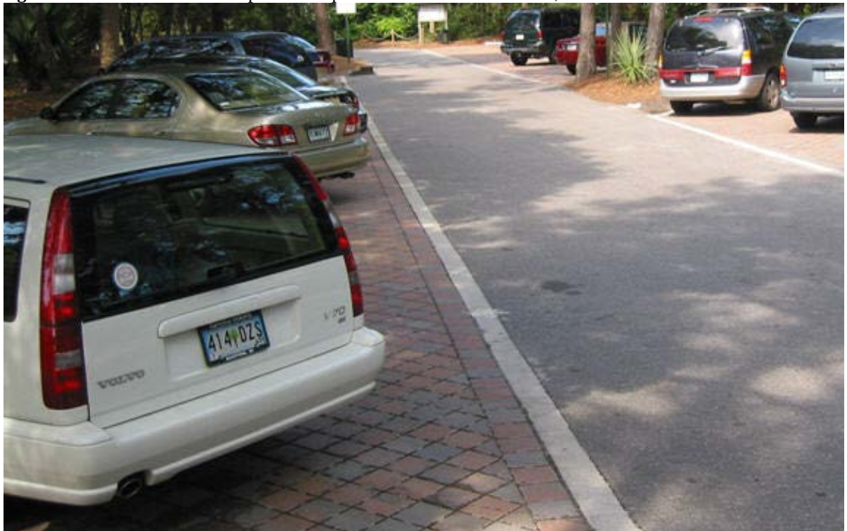
Figura 19. Estacionamento com pavimento permeável em South Carolina, Estados Unidos.
