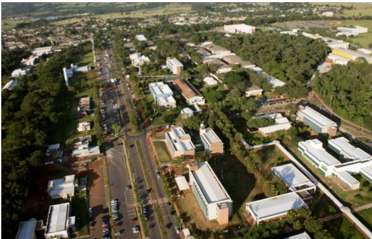
Figura 75. Vista aérea do anel viário do Campus Samambaia , UFG, sentido leste.
