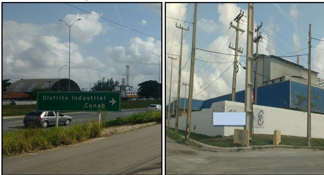
6 - Placa indicando acesso ao DI de João Pessoa às margens da BR 101.
