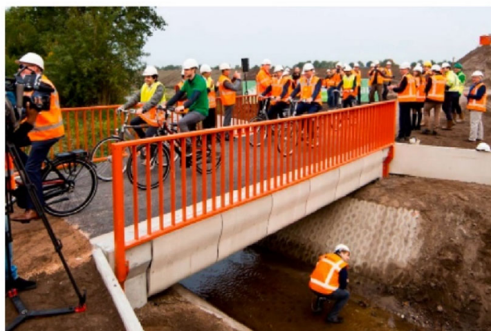
Figura 4 - Ponte em 3DCP instalada na ciclovia Lieve Vrouwensteeg, na vila de Gemert, na Holanda
