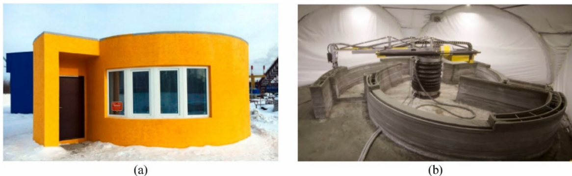
Figura 5 - (a) Vista frontal da Casa Apis Cor na Rússia; (b) Processo de Contour Crafting na Casa Apis Cor
