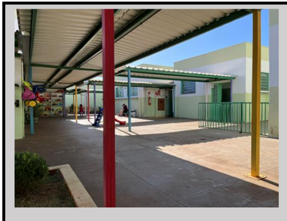
Foto 10 – Vista externa do bloco do Ciclo II
