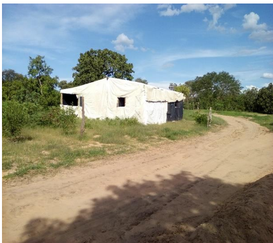
Figura 9 - Moradia no Santa Rita II
