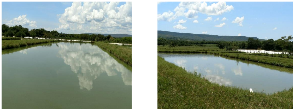
Figura 4 - Tanques para piscicultura de cativeiro no projeto Codevasf São Desidério/Barreiras Sul
