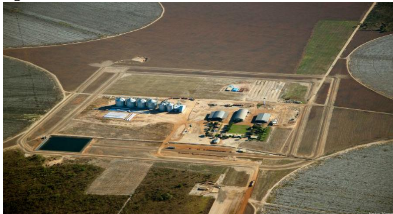
Figura 5 - Vista aérea da fazenda Palmares em Barreiras-BA
