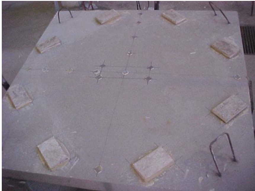
Figura G.9 – Marcação da laje e fixação das placas
