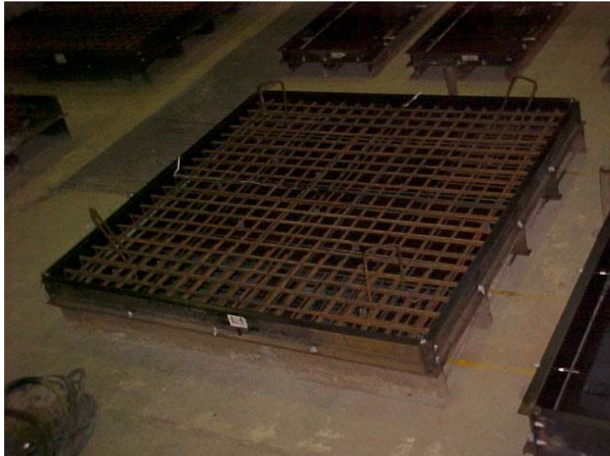
Figura G.1 – Forma montada para concretagem
