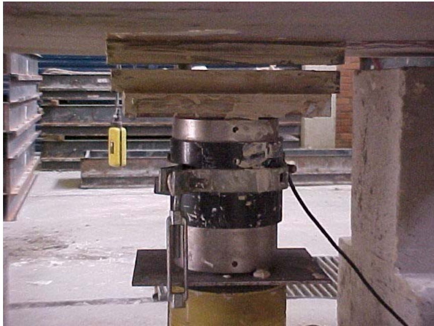
Figura G.11 – Detalhe das placas do pilar e célula de carga
