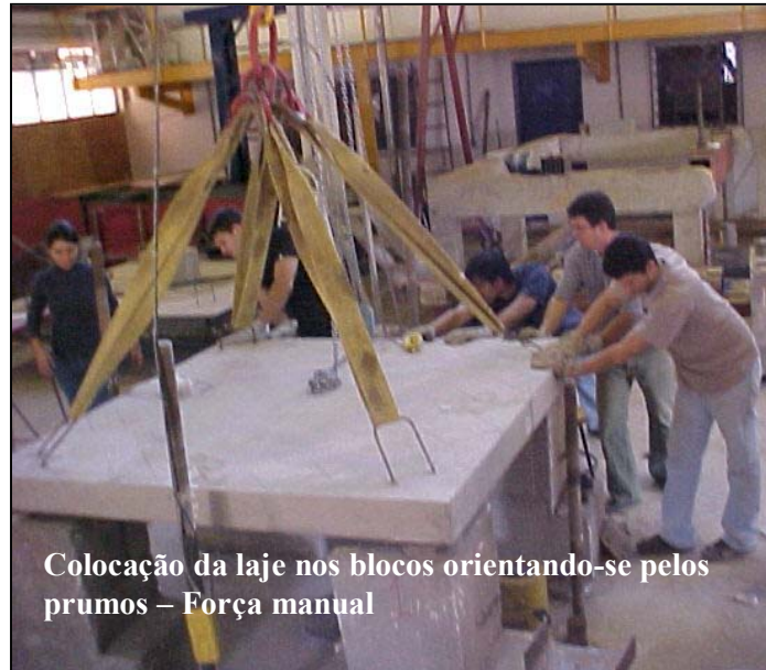
Figura 3.8 – Detalhes do processo de posicionamento das lajes
