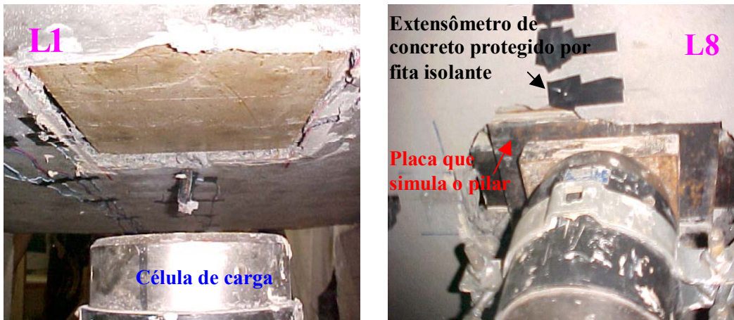
Figura 4.35 – Fotografias das lajes L1 e L7 ensaiadas após a ruptura – vista inferior
