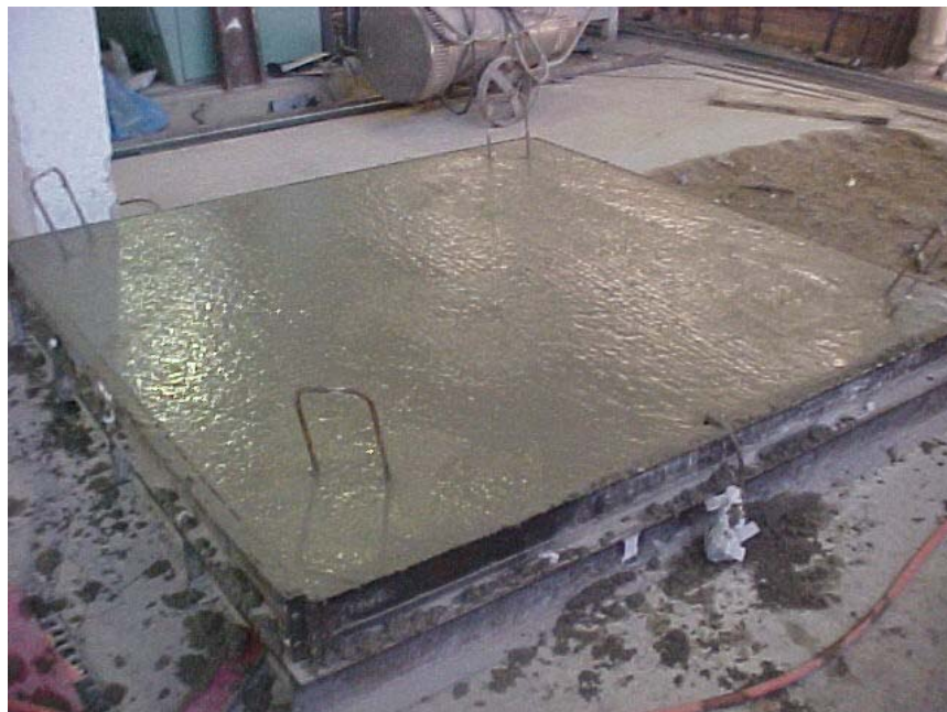
Figura G.4 – Laje concretada
