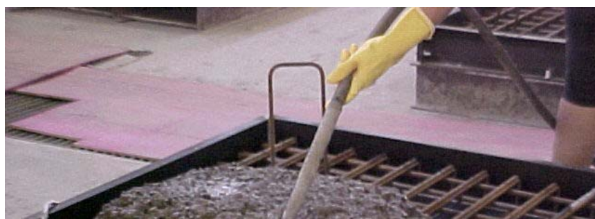
Figura G.2 – Lançamento do concreto na forma
