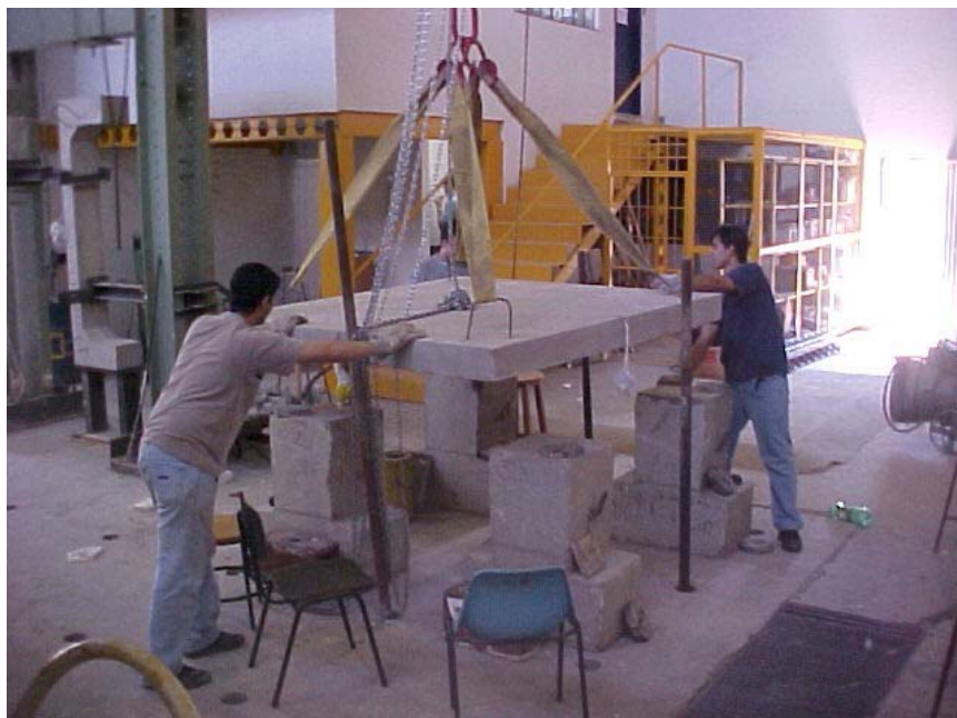
Figura G.6 – Colocação da laje nos blocos de apoio
