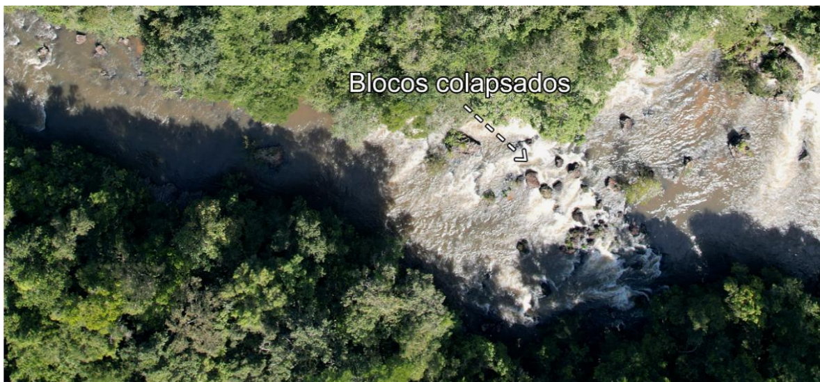
Figura 11 - Blocos colapsados no Rio Ponte de Pedra
