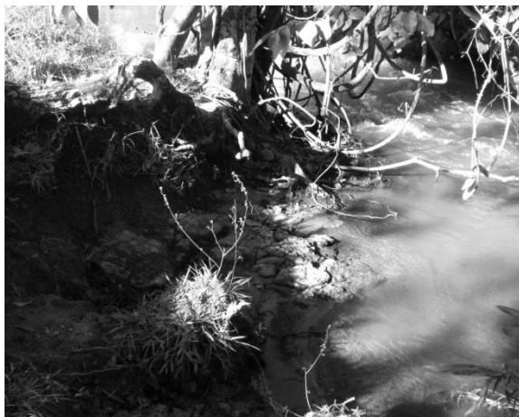
1 2 Figura 3 - Erosão aparente na margem 3 do Manancial A, localizado no município 4 de Goianópolis/GO.
