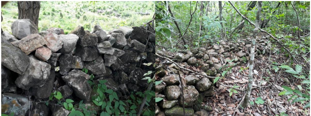
Figura 5 Antiga cerca de contenção em Santa Rita (povoado que remonta ao século XVIII). Acervo Pessoal (Santa Rita, 2017)
