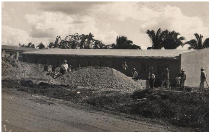
Imagem 16: Construção da Futura Maternidade Dom Orione – Araguaína, 1975
