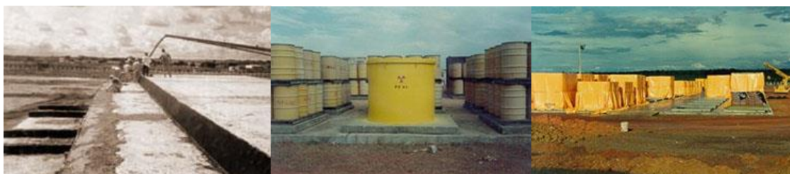
Figura 23 – Construção do depósito definitivo para armazenar os rejeitos do Césio 137
