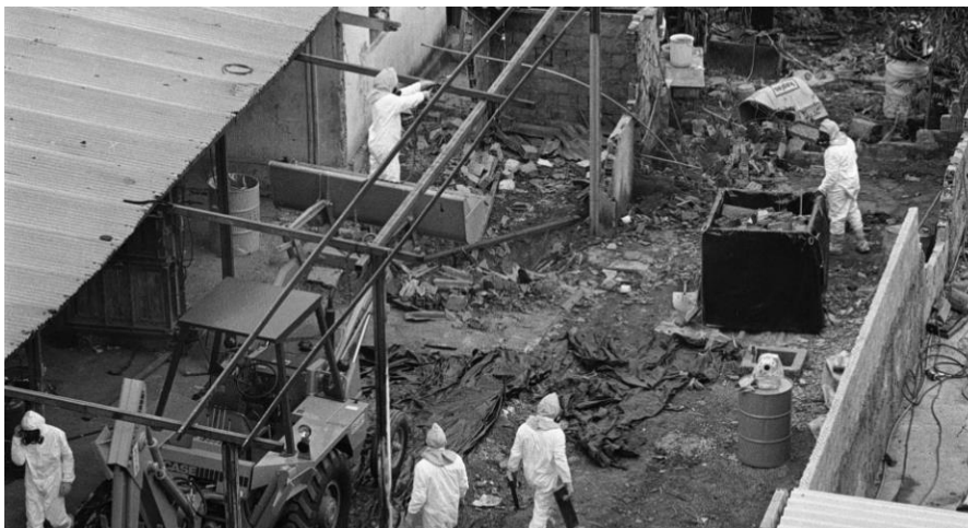
Figura 20 – Demolição de casas contaminadas
