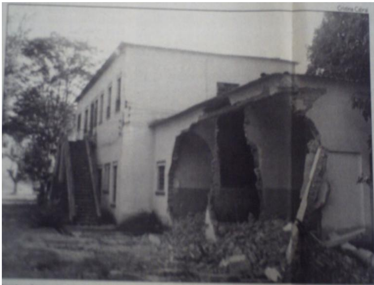
Demolição do Prédio do Hospital Psiquiátrico Prof. Aduino Botelho em 1997. Jornal O Popular.
