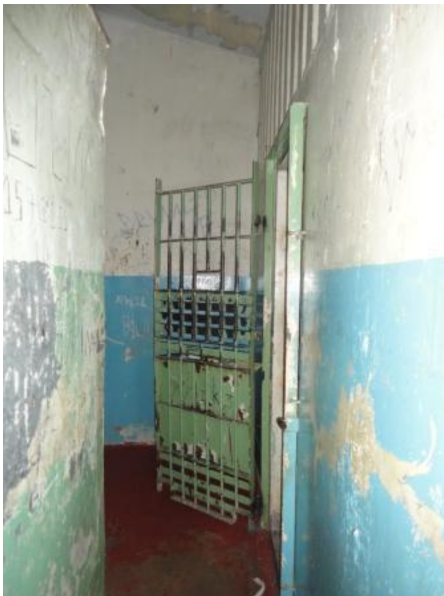
Foto 13: Corredor de acesso ao Alojamento V
